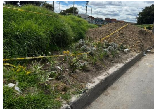
Fotos del después de la intervención del punto crítico
