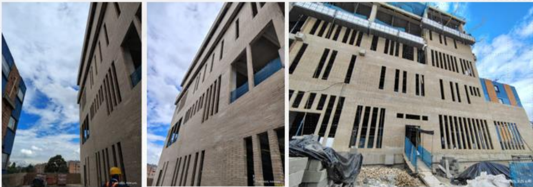
Mampostería en fachada
