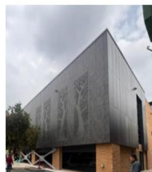
Fachada Centro de Salud 29
