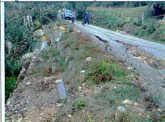
Fotografía 5. Columnas de bambú con inclinación leve hacia el occidente.
