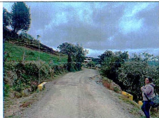
Fotografía 1. Vista general del tramo vial evaluado.
