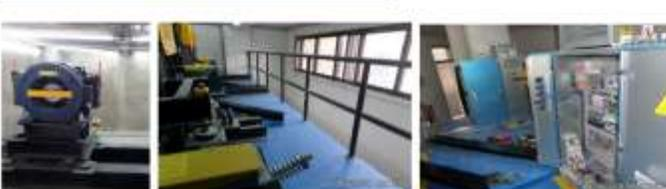
INSTALACIÓN DE MOTORES Y CONEXIONES ELÉCTRICAS EN CUARTO DE MÁQUINAS ASCENSORES N.2 Y N.3
