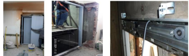
Montaje nuevos equipos para Ascensores No. 1 y No.4
