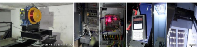
Montaje de motor y sistema eléctrico para Ascensores No. 1 y No.4
