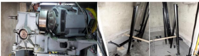
Desmonte de Ascensores No. 1 y No.4
