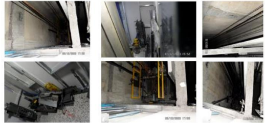
Desensamble de soportes y rieles guía y accesorios , ascensor No. 1
