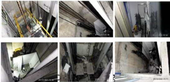
Desmantelamiento de cabina de ascensor No. 1
