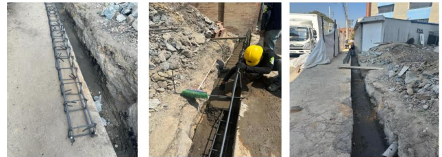
Obra civil para cerramiento perimetral
