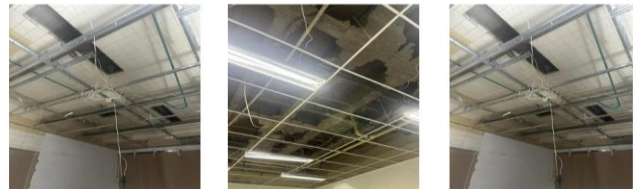
Desmante de estructura de cielo raso angiografo. Desmante de superboard cielo raso angiografo
