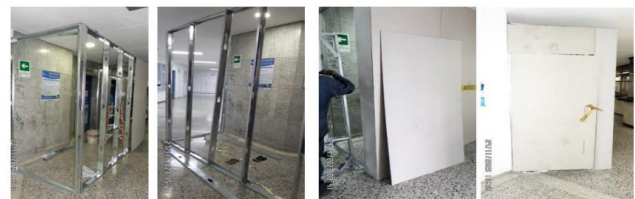
Construcción de encerramiento de área de ascensor No. 1
