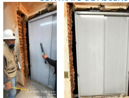
Instalación de soportes y rieles guía sección superior ascensor No. 1 y No.4
