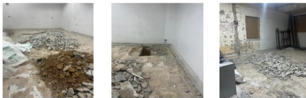
Demolición de piso angiografo.
