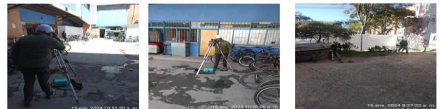
Levantamiento topográfico área plazoleta unidad renal. Desmante de cerramiento exterior.
