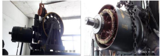
Desensamble y retiro de Maquina de ascensor No. 1
