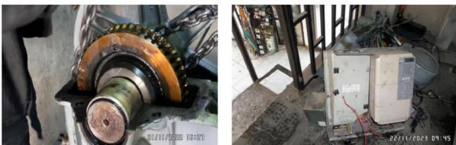
Desmantelamiento de máquina de ascensor No. 4
