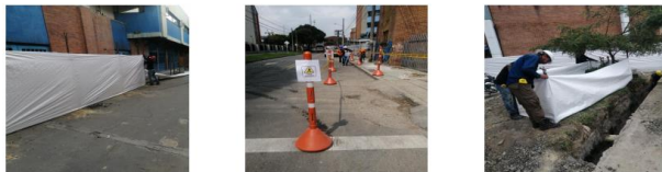
señalización de paso peatonal y cerramiento de la parte de vegetación
