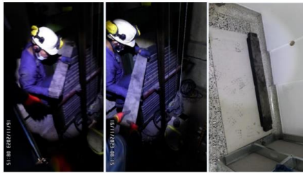
Desmantelamiento del sistema de contrapeso ascensor No. 4
