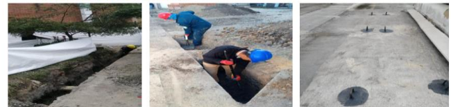
Excavación de viga para instalación de cerramiento Excavación de viga para instalación de cerramiento Instalación de anclajes para mantenimiento y de fachadas.
