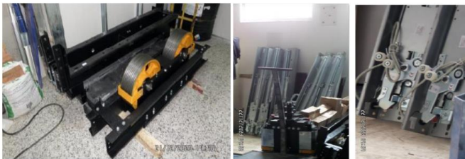
Preensamble y alistamiento de componentes de ascensor No. 4 y No. 1
