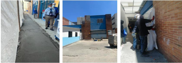
Adecuación de rutas de acceso personal hospital Actividades de mantenimiento de fachadas Cerramiento plazoleta unidad renal
