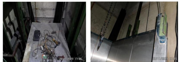
Desmantelamiento de cabina de ascensor No. 4
