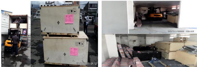
Recibo y traslado de nuevos ascensores al lugar de acopio
