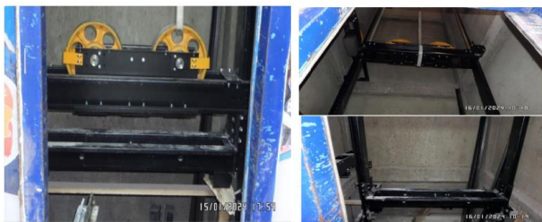
Ensamble de marco de cabina y plataforma (piso) ascensor No. 4
