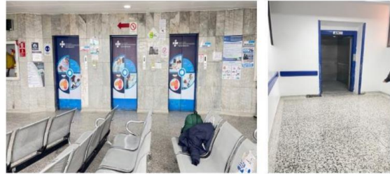
INSTALACION DE 4 EQUIPOS NUEVOS , 6 PARADAS
