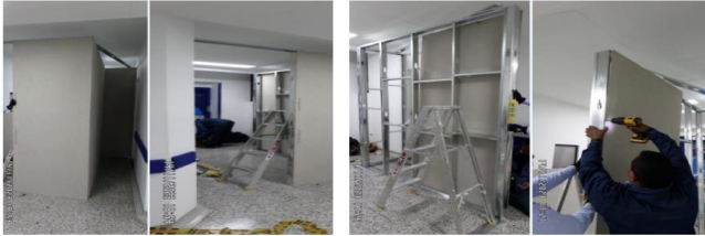
Delimitación de acceso a ascensor No. 4. Construcción de confinamiento
