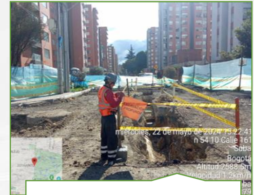
Imagen 4. Se realizaron mantenimientos de los pasos, senderos peatonales, acceso seguro a viviendas, cerramiento en general del proyecto.
