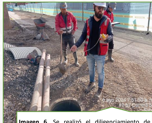
Imagen 6. Se realizó el diligenciamiento de permisos e inspecciones para frentes de trabajo en conjunto con las herramientas maquinas y equipos.
