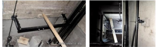
Se instalan soportes y rieles guía en foso ascensor No. 4
