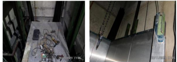
Desmantelamiento de cabina de ascensor No. 4
