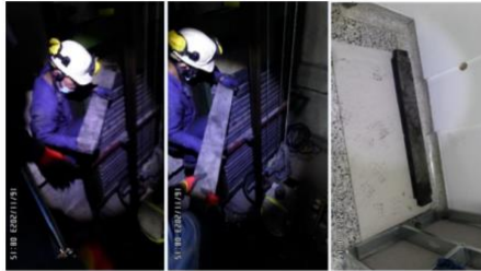
Desmantelamiento del sistema de contrapeso ascensor No. 4
