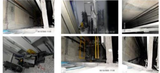
Desensamble de soportes y rieles guía y accesorios , ascensor No. 1
