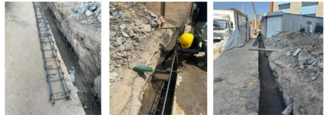
Obra civil para cerramiento perimetral
