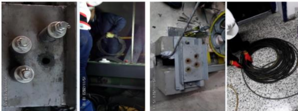
Retiro de cables de tracción de ascensor No. 4
