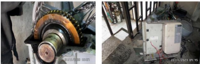
Desmantelamiento de máquina de ascensor No. 4
