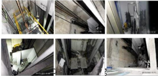
Desmantelamiento de cabina de ascensor No. 1
