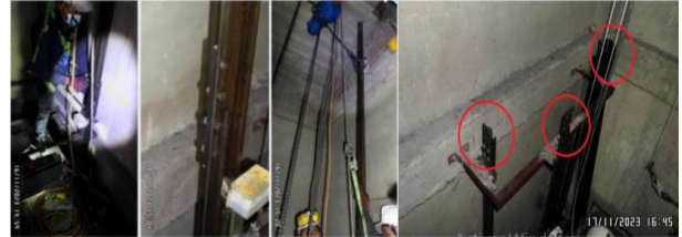
Desmorte de sistema de rieles guía y soportes de ascensor No. 4
