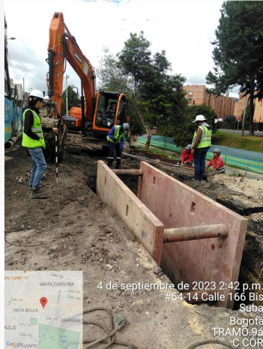
Construcción Alcantarillado Pluvial
