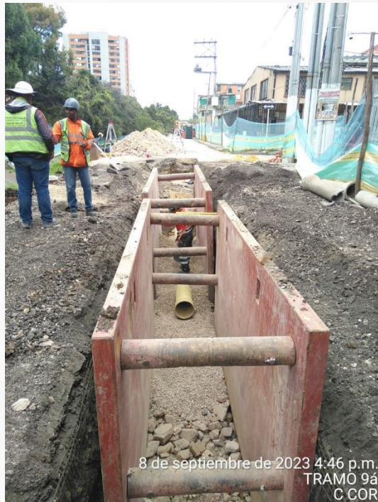
Construcción Alcantarillado Pluvial
