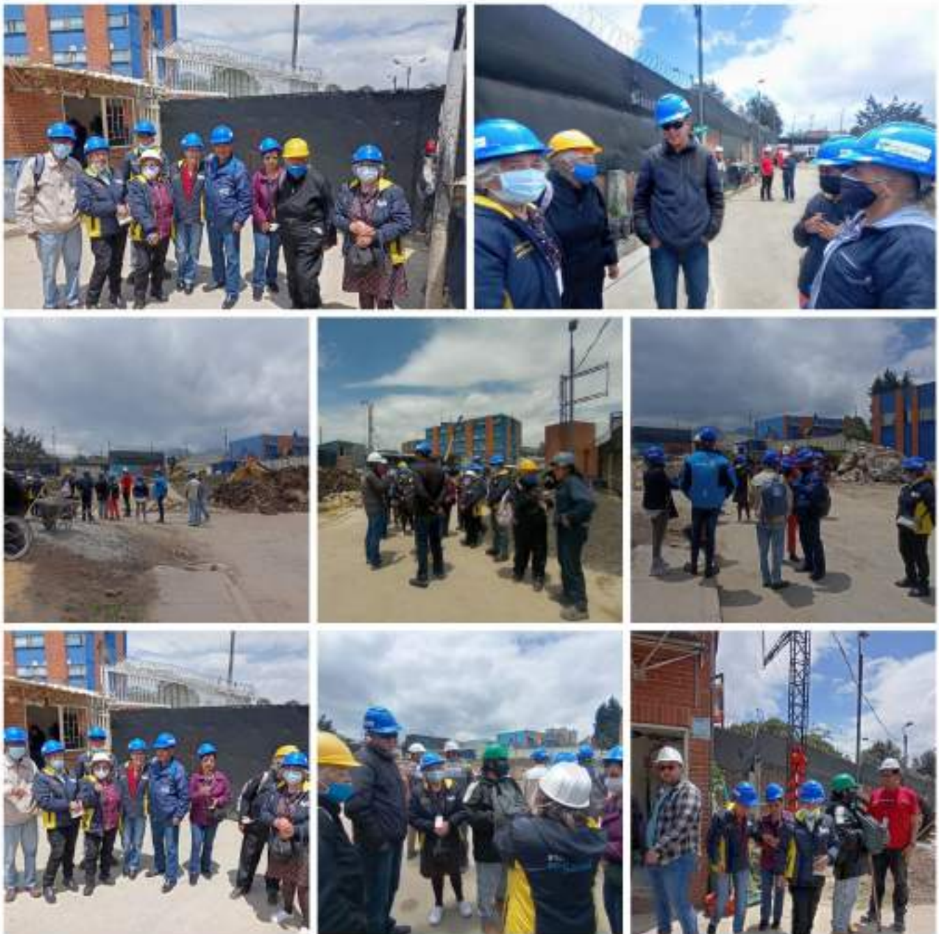
Registro fotográfico recorrido a Obras de Reorganización Urgencias – Abril 15 de 2023
