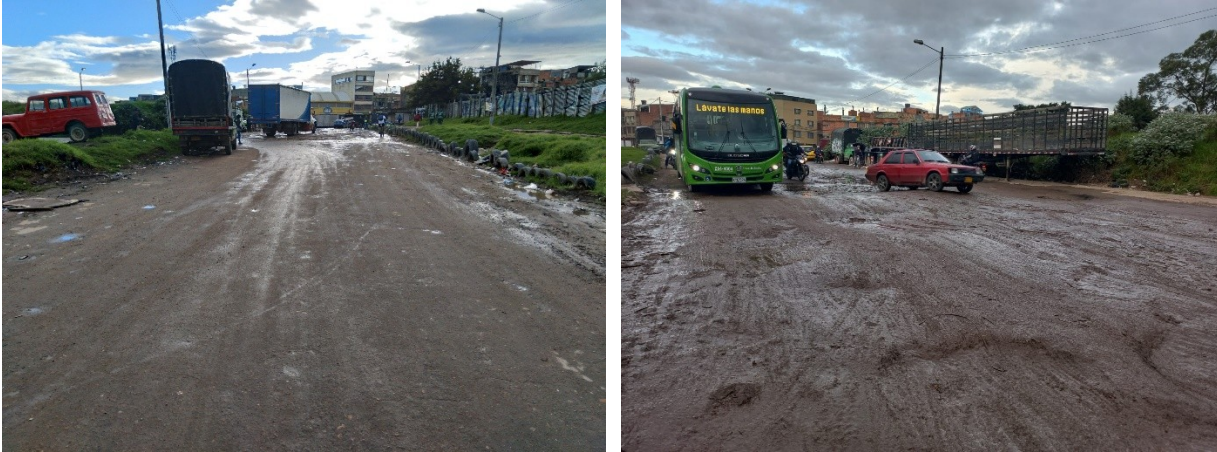
Figura 1 – Carrera 119D entre Calle 129 y Avenida Carrera 118
