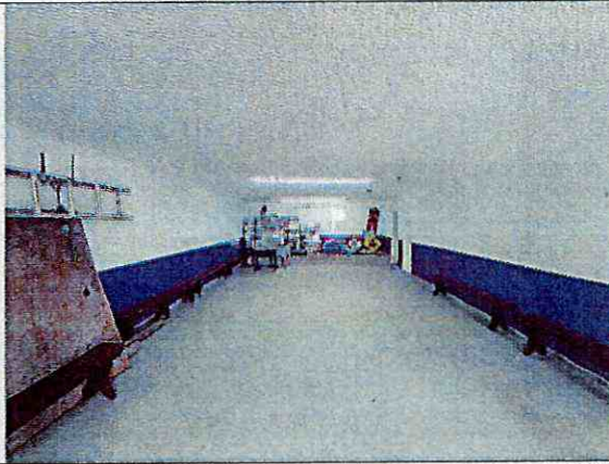
Fotografía 24. Vista general del primer piso de P1B
