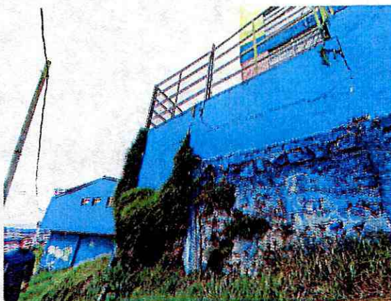
Fotografía 20. Muro Sur en suroccidente de P1A. Tomado el 18/07/2022
