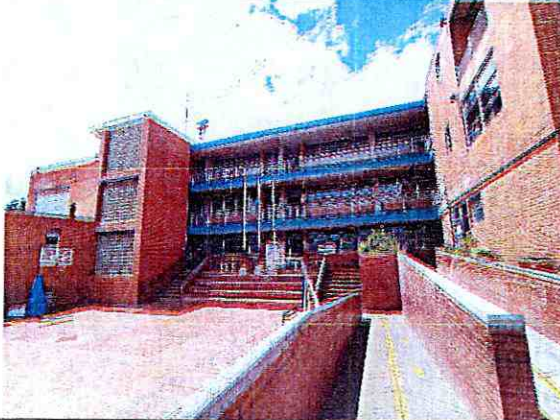
Fotografía 5. Vista general del interior de la Construcción P1A
