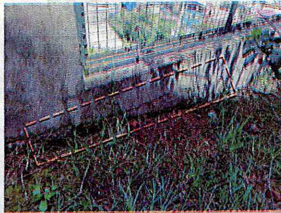
Fotografía 10. Muestra de fisuras en muro Sur de P1A. Tomada el 18/07/2022
