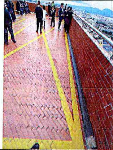
Fotografía 4. Mediacañas en unión placa de entrepiso-muro de fachada, visto desde el interior
