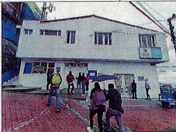
Fotografía 23. Fachada de P1B, sobre KR 1 Bis
