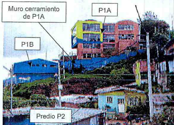
Fotografía 14. Muro de cerramiento Sur de P1A. Tomado del DI-17609 (26/06/2022)
