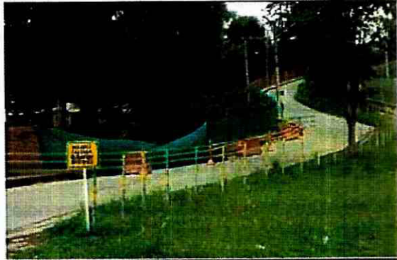
Foto No. 4. Tramo vial afectado Tv. 77 a la altura de la Calle 162 y Calle 165. Tomado de RO-48439 de abril de 2011
