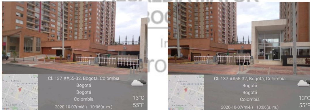
Imagen 4. Registro fotográfico pozo 74 ubicado en la calle 137 # 55 34
