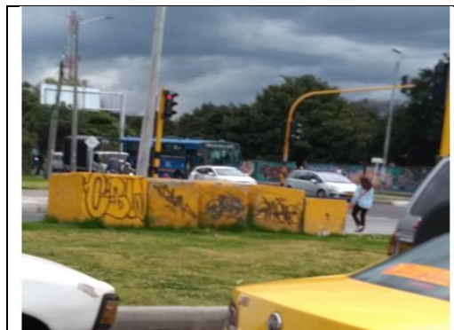
Foto 4: Separador central costado oriental
