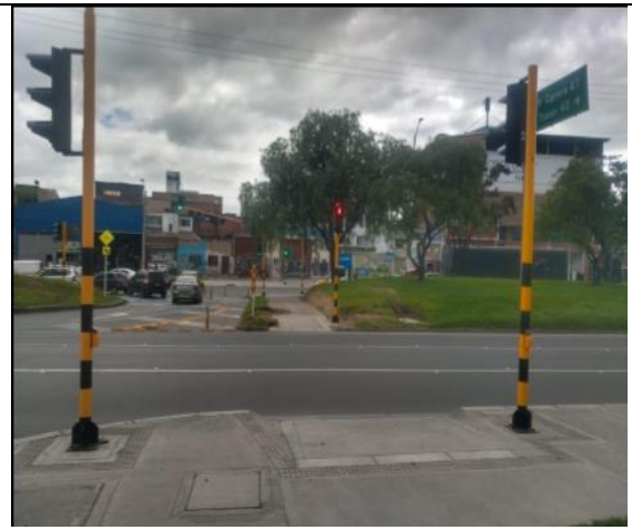
Foto 2: Intersecciones nuevas con sonoros
