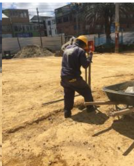
EXCAVACIÓN MANUAL PARA PILOTES
