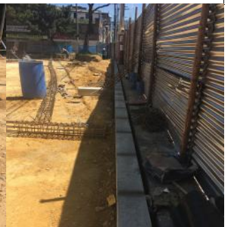
SUMINISTRO E INSTALACIÓN BORDILLO PREFABRICADO A 80
