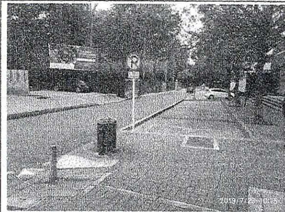
Fotografía 21. Panorámica Calle 87 con Carrera 11, vista al Occidente.
