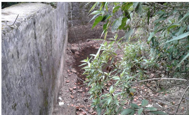
Imagen 11. Estado actual antigua fuente de acueducto comunitario
