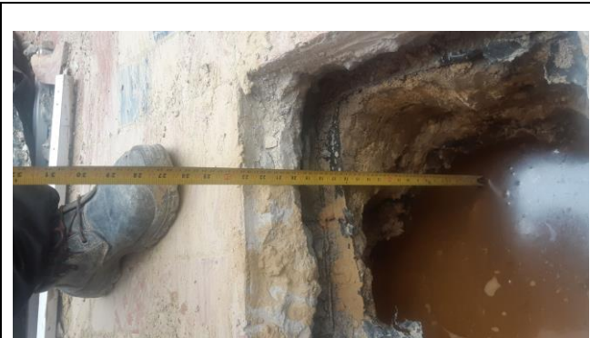
Fotografía 11. Profundidad de cimentación
