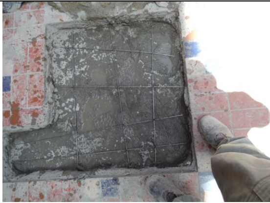
Fotografía 13. Conformación y acero para reparación de losa
