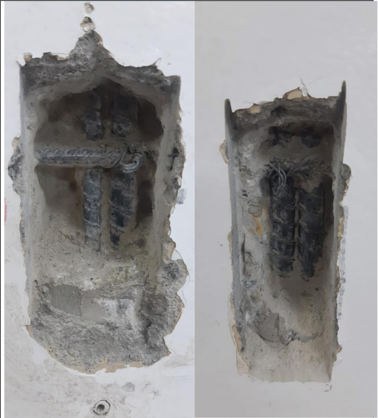
Fotografía 25. Aceros longitudinales de \frac{1}{2} y \frac{5}{8} corrugado columnas primer piso
