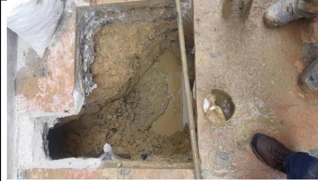
Fotografía 9. Corte de losa contrapiso
