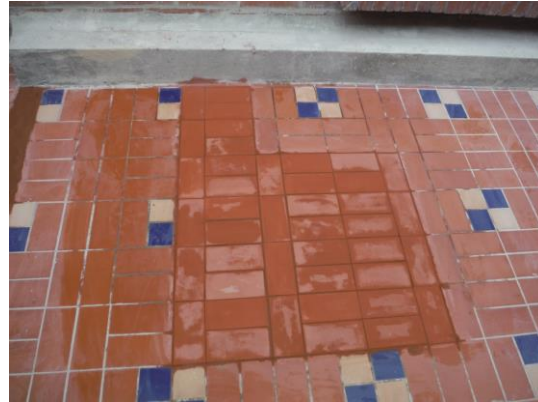
Fotografía 14. Estado final de reparación de losa
