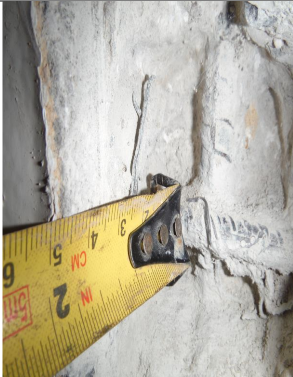
Fotografía 27. Medición de recubrimiento de acero de 3cm en columna primer piso
