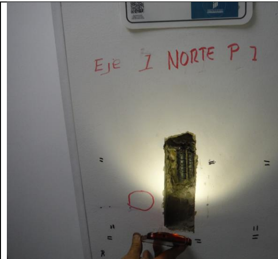
Fotografía 17. Acero longitudinal corrugado
