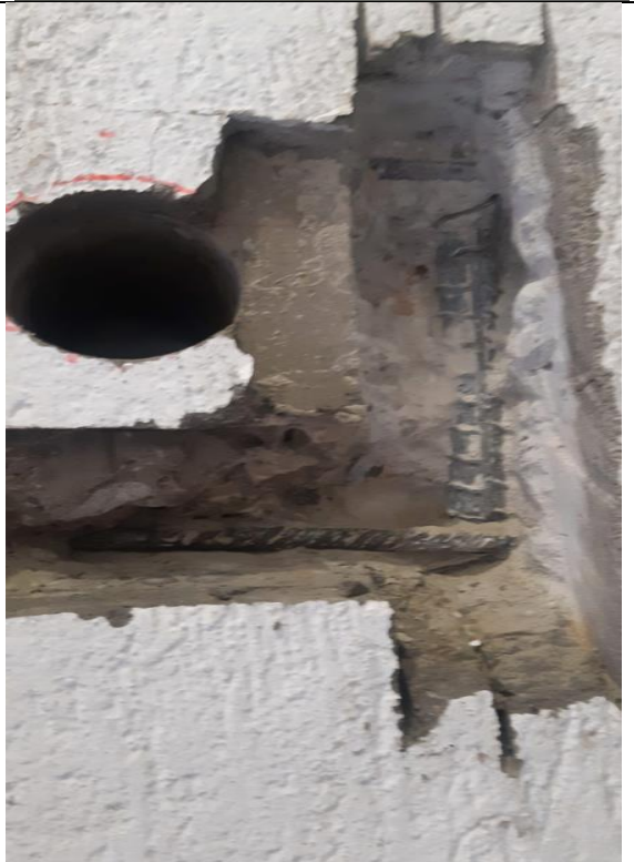
Fotografía 28. Aceros y orificio de núcleo extraído
