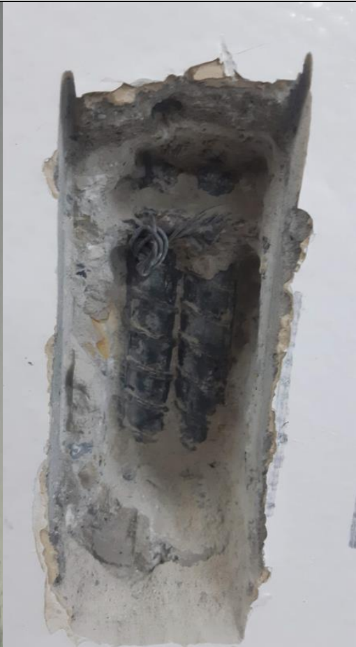
Fotografía 24. Acero longitudinales
