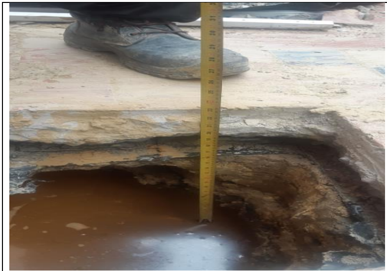
Fotografía 15 Auscultación cimentación costado occidental
