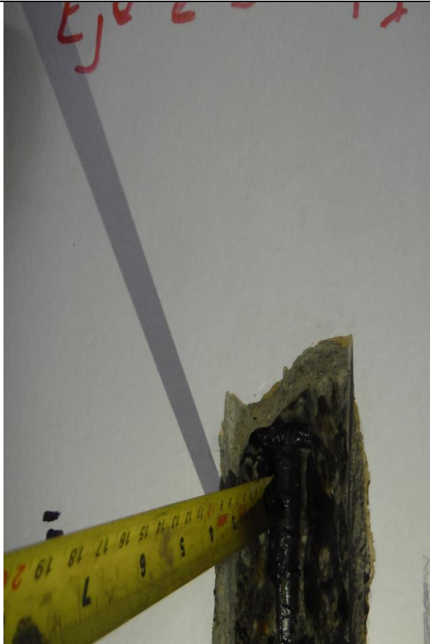
Fotografía 23. Medición de recubrimiento de acero de 3cm en columna primer piso
