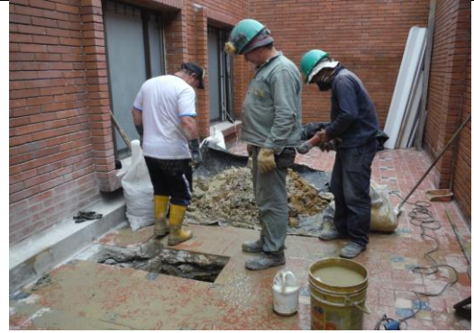
Fotografía 10. Corte de losa contrapiso, auscultación cimentación
