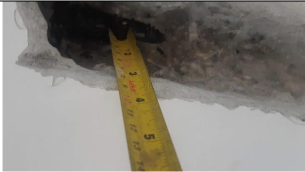
Fotografía 26 . Medición de recubrimiento de acero de 3cm en columna segundo piso
