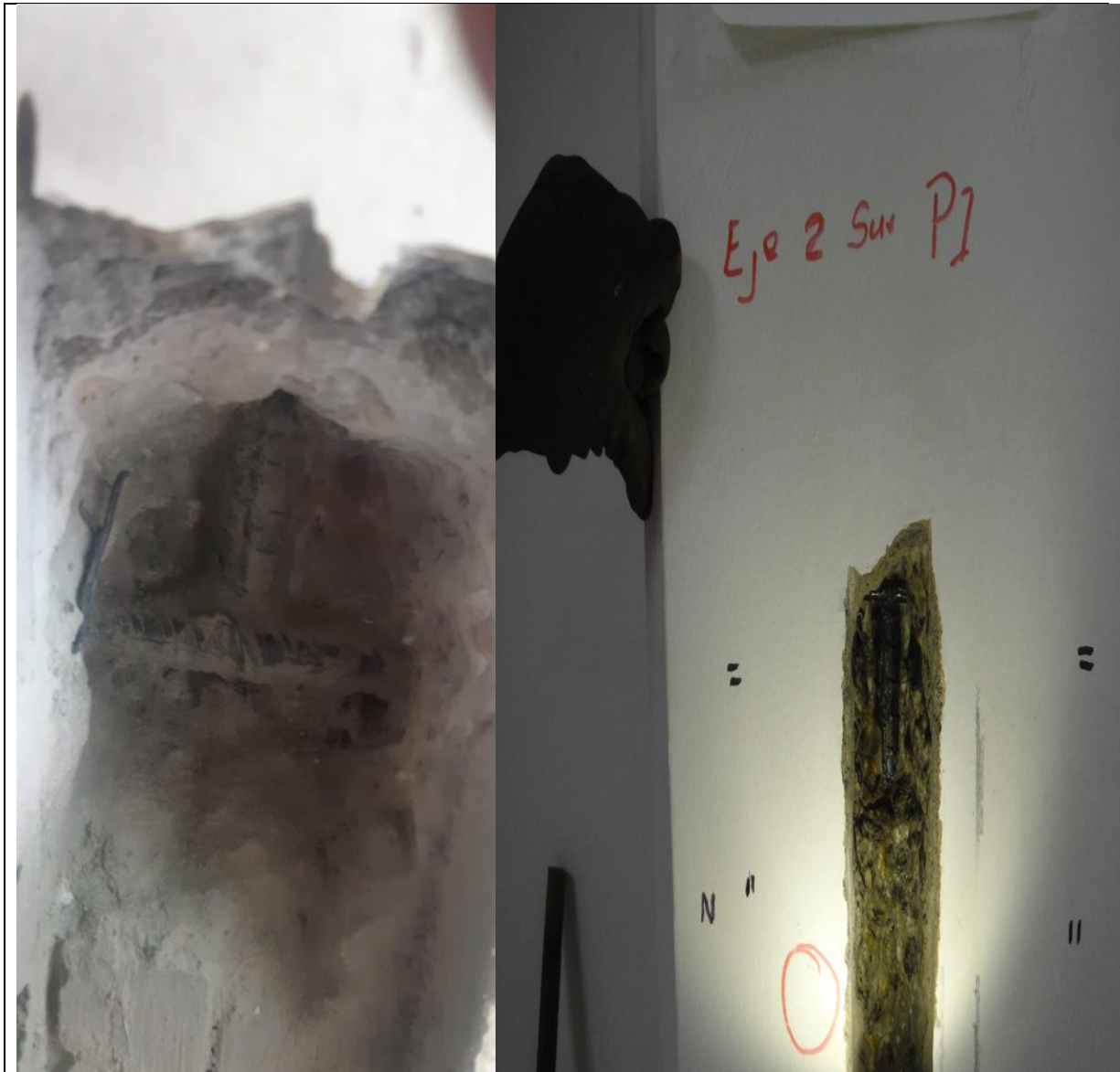
Fotografía 21 . Flejes en acero 3/8 pulgadas en acero corrugado y longitudinal de 1/2 en columna primer piso
