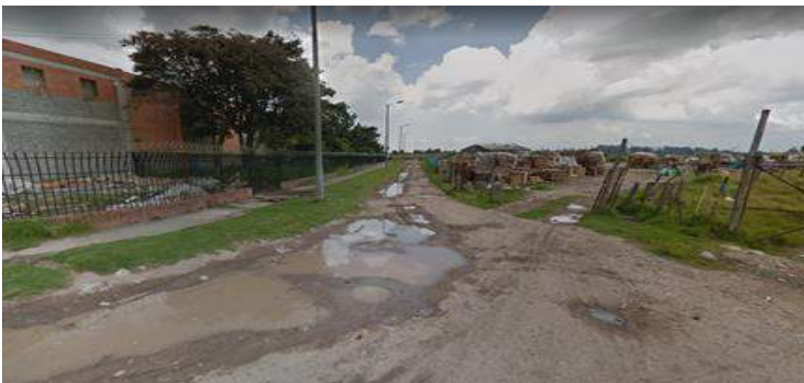
Figura 110. Estado de la malla vial en la localidad de Fontibón
