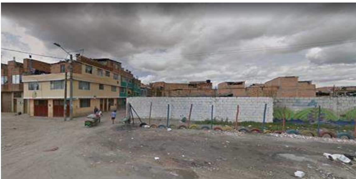
Figura 109. Estado de la malla vial en la localidad de Kennedy
