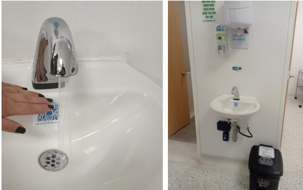
Imagén N°03, mantenimiento de unidades sanitarias
