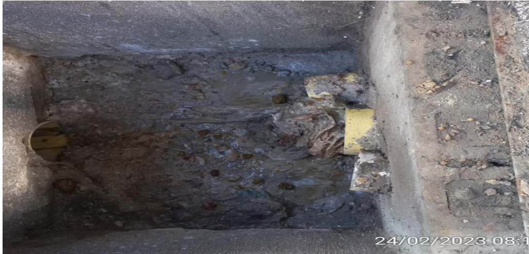
Imagén N°02, mantenimiento de tuberías
