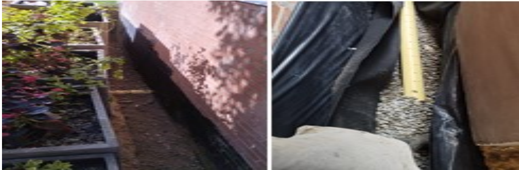
Imagen N°06, Filtros de agua
