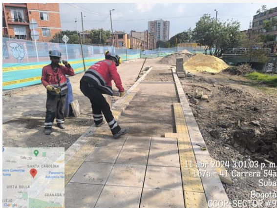
Instalación de prefabricados
