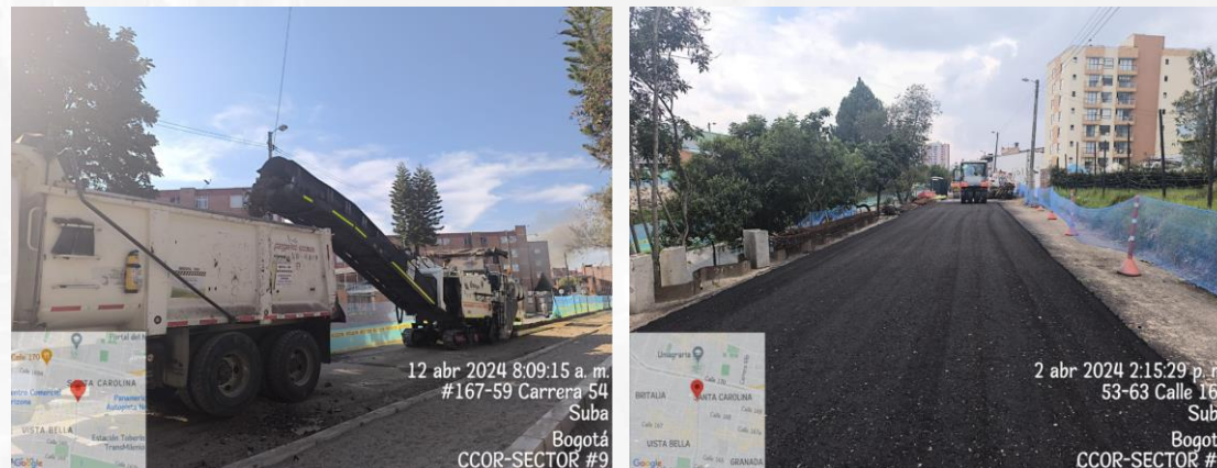
Fresado de vía e instalación de MGEA
