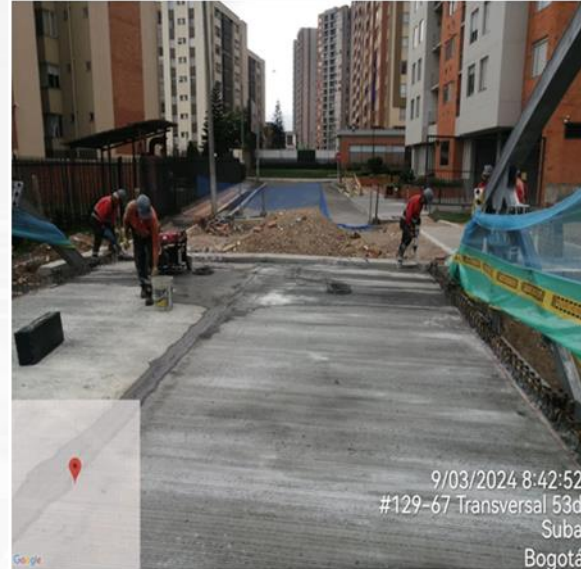
Construcción de losa en concreto para puente calle 130
