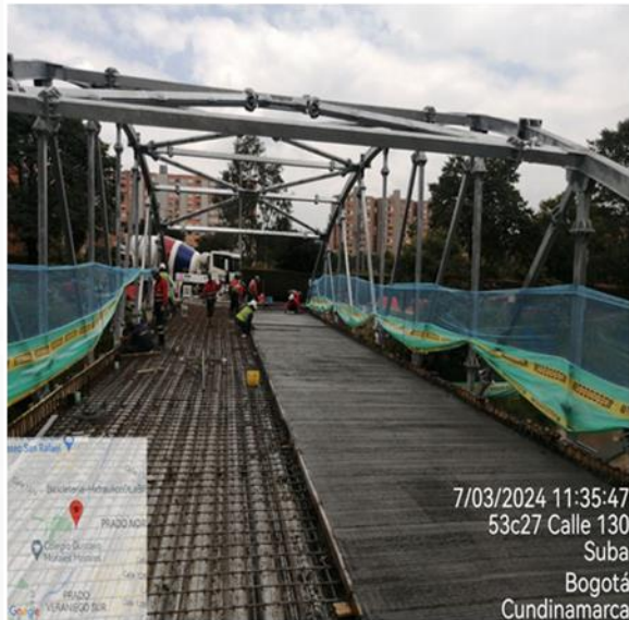
Construcción de losa en concreto para puente calle 130
