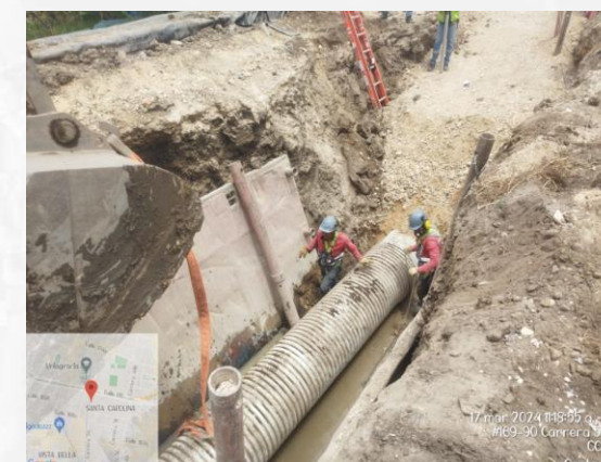
Instalación alcantarillado sanitario 30"
