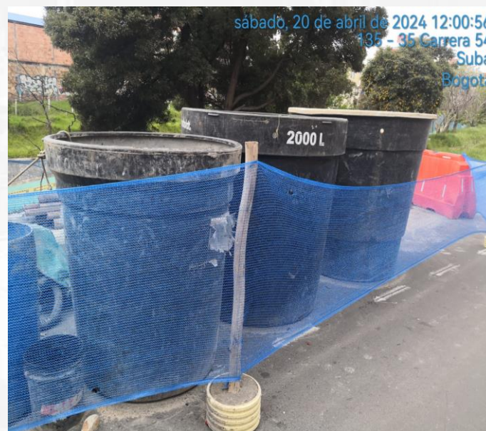
Almacenamiento de agua lluvia para reusar en procesos de pilotaje y excavaciones.
