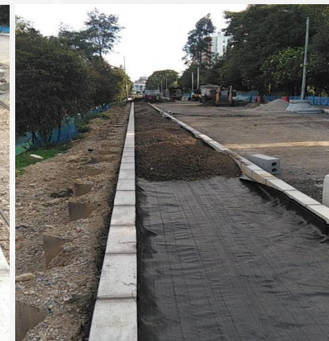
Instalación de geotextil y material granular subbases relleno sendero peatonal
