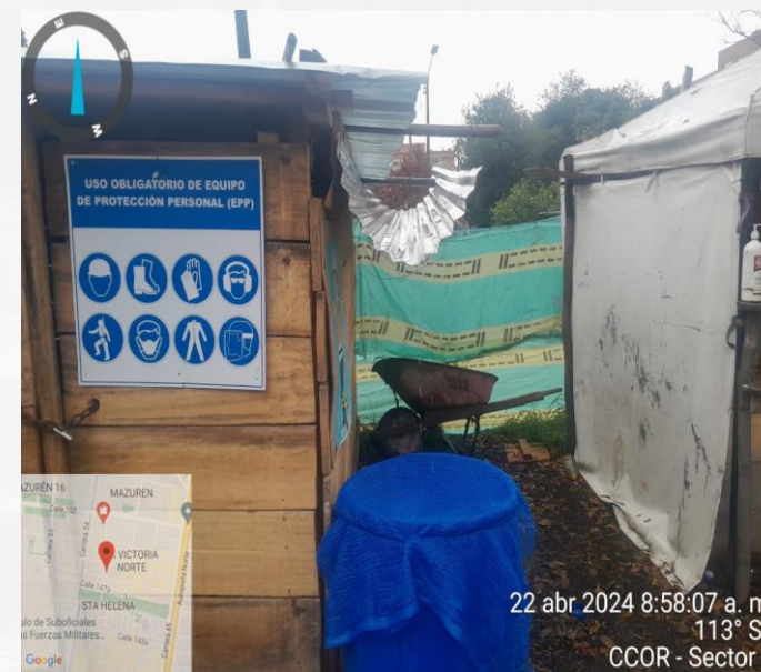
Adecuación campamentos para recolección de agua lluvia.
