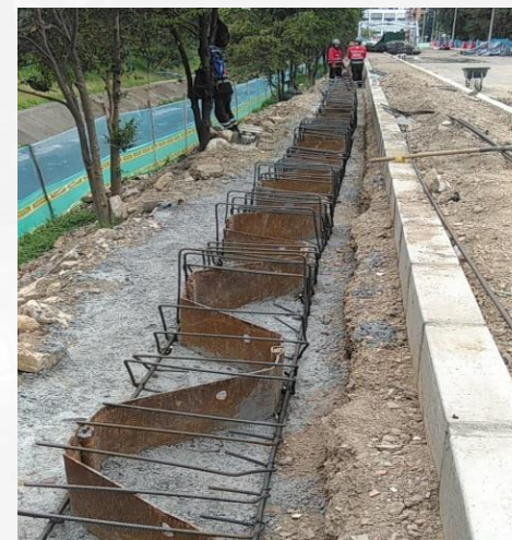
Armado de acero para viga tablestaca borde de sendero peatonal
