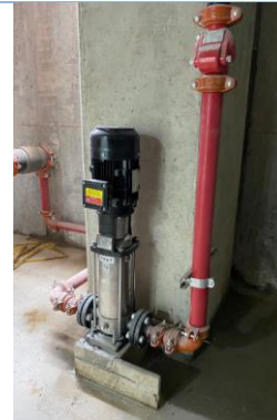
Instalación de equipos RCI
