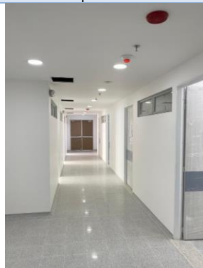
Avance en pasillos BLOQUE A P2
