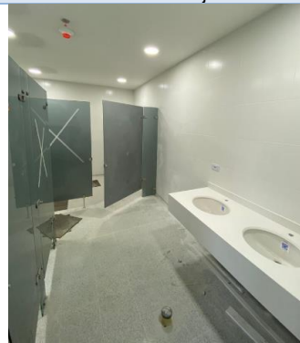
Avance en baños
