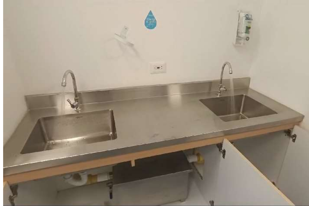
Instalación de trampa de yesos y habilitación de griferías
