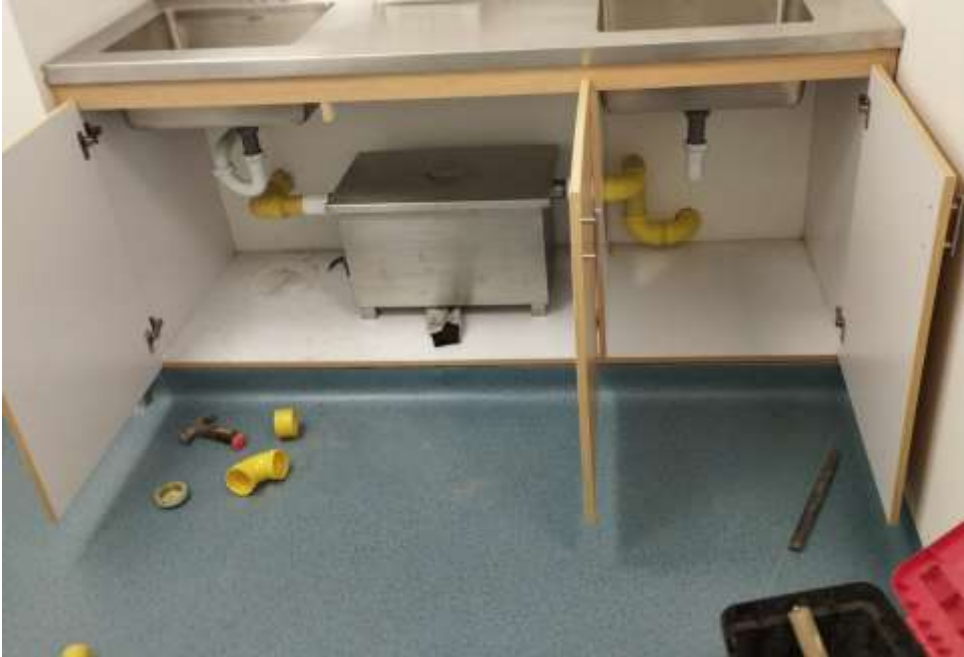
Instalación de trampa de yesos y habilitación de griferías
