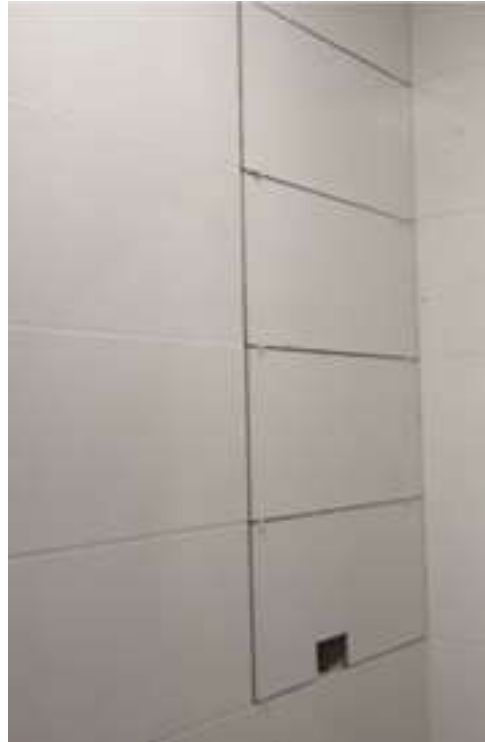
Regatas para instalación de tomas requeridas para terapia física y sala de paz
