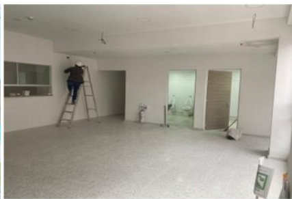
Instalación de aparatos eléctricos, puertas, porcelana sanitaria y pintura segunda mano
