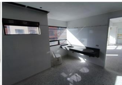
Instalación de mesones de baños y brillo de pisos
