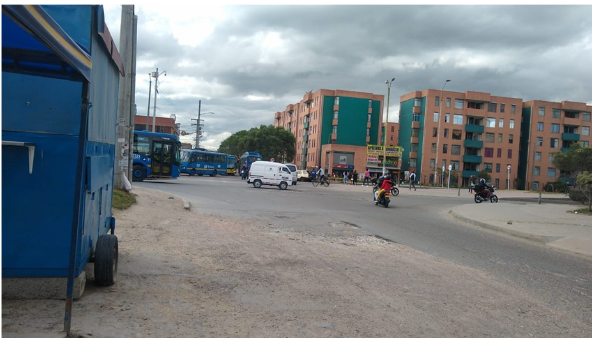
Foto dos recorridos 9 de mayo, Carrera 95A con calle 73
