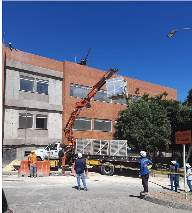
Izaje equipos de cubierta
