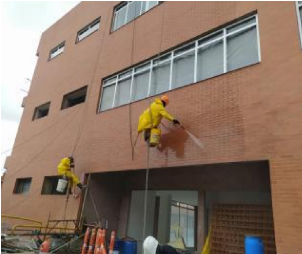
Avance de Lavado de Fachada
