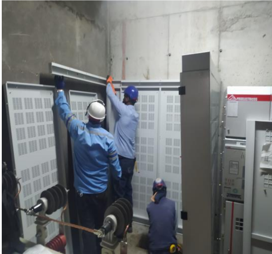
Avance de instalación de Subestación
