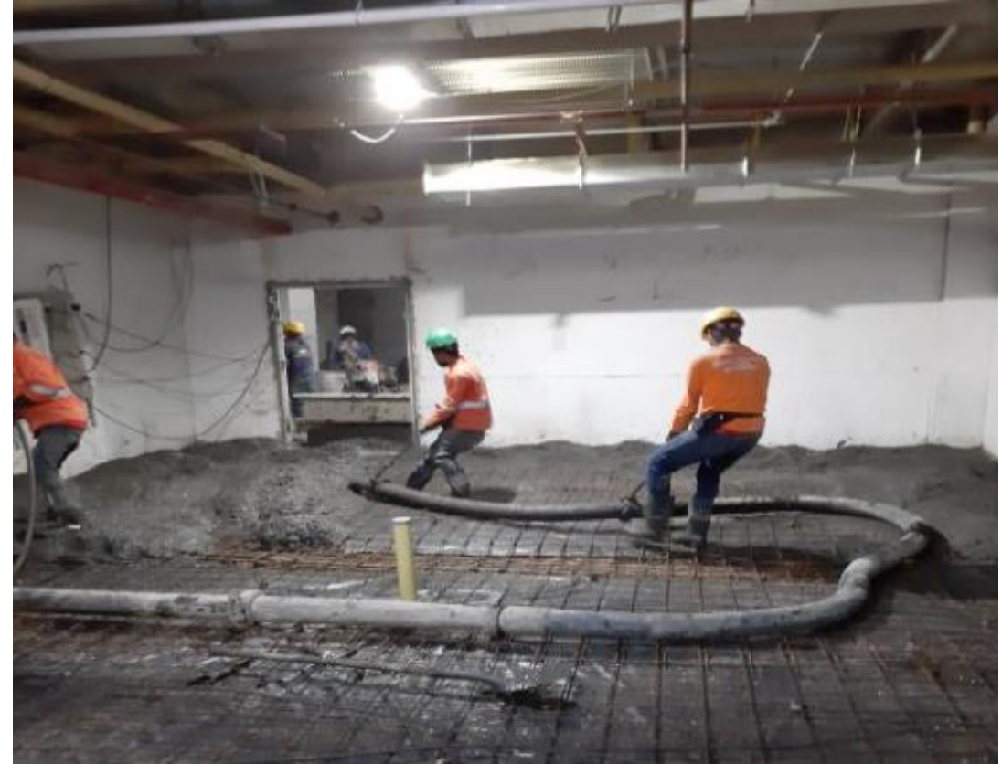
Fundición de Contrapiso Sótano
