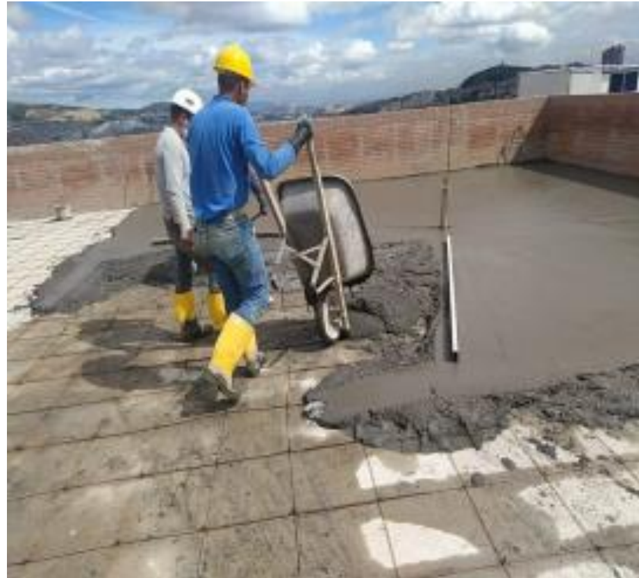
Avance de nivelación de cubierta
