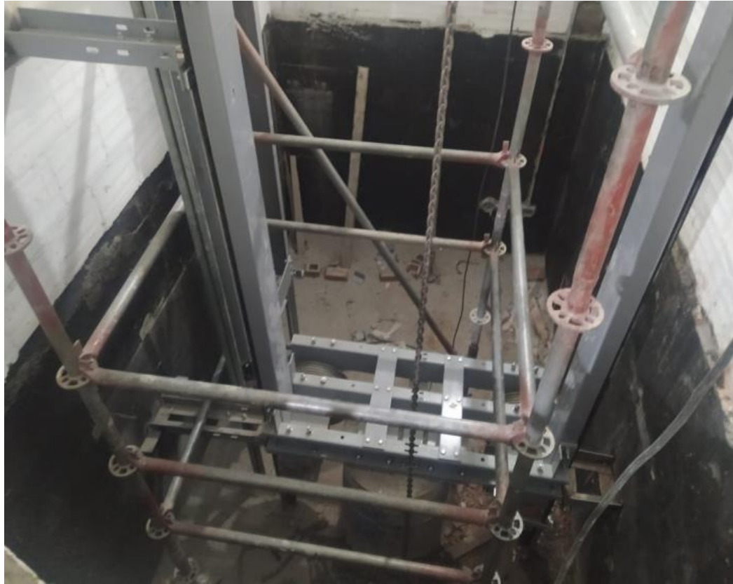
Avance de instalación de ascensores
