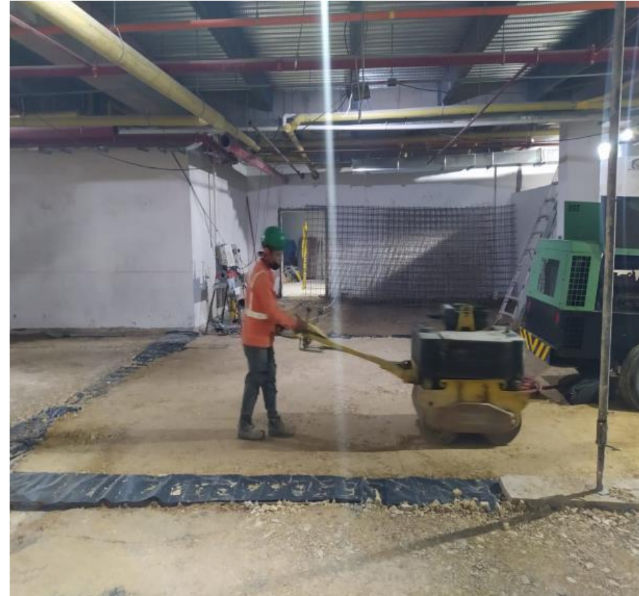
Avance de Contrapiso Sótano
