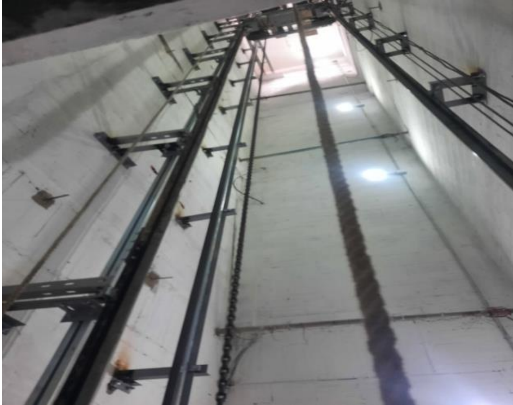
Avance Instalación Ascensores.
