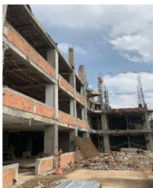
Construcción punto fijo y muros perimetrales. Centro de Salud Tunal.
