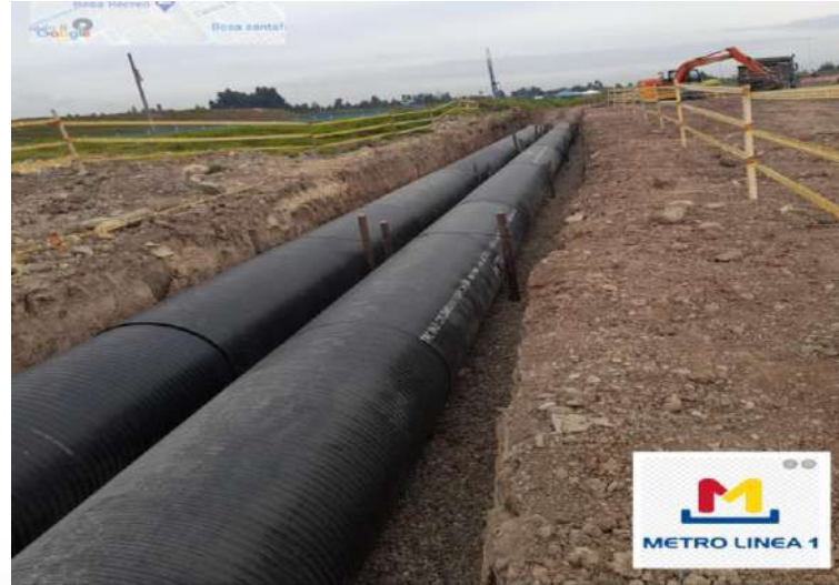
Implementación de medidas de seguridad industrial en obra
