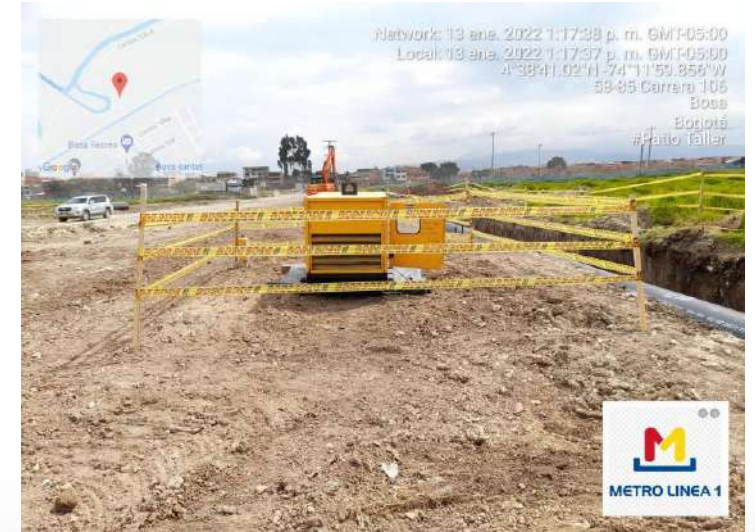
Señalización de obra
