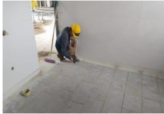
Avance de acabados en pisos y cielos
