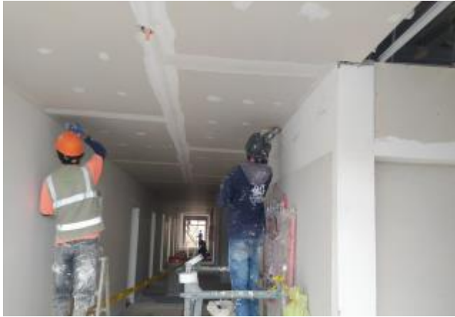
Avance de Acabados
