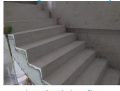
Avance de acabados en Pisos
