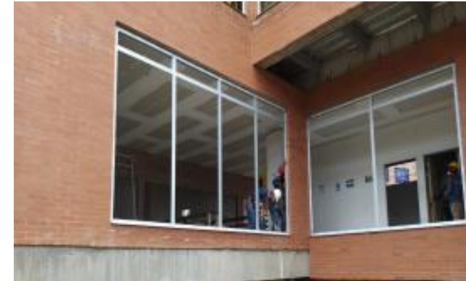
Avance instalación de ventaneria en fachada
