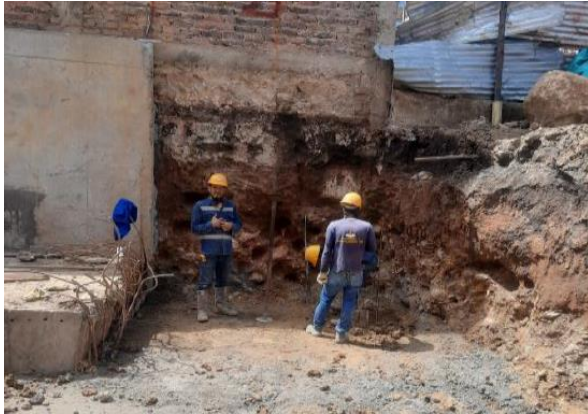
Excavación y Perfilado de terreno ULTIMA trinchera.
