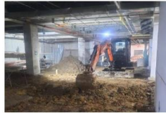
Compacción de Sótano Para armado de contrapiso
