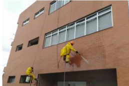
Lavado, sellado e Impermeabilizado de Fachada
