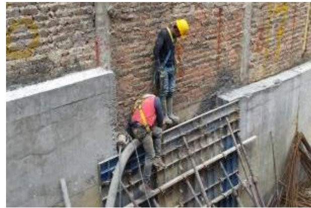
Avance de Fundición de Muro Contención.
