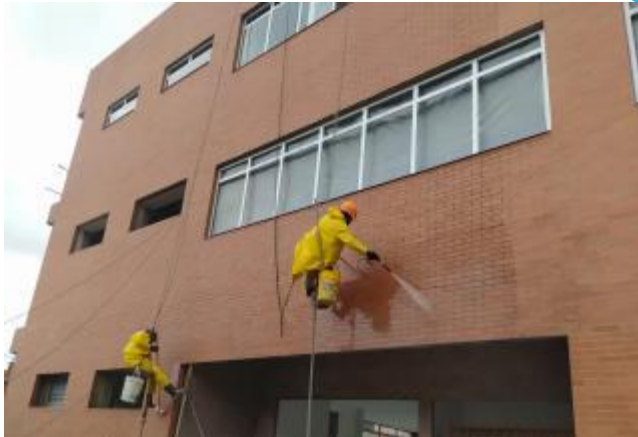
Lavado, sellado e Impermeabilizado de Fachada
