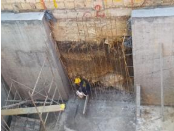
Avance Muro de contención.
