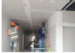
Avance de Acabados
