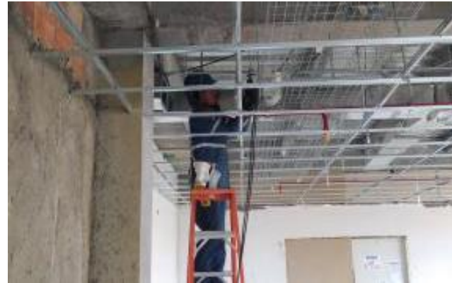
Avance instalación de redes
