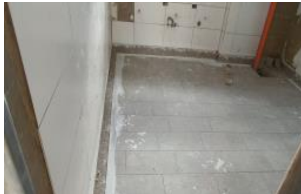
Avance instalación enchapes
