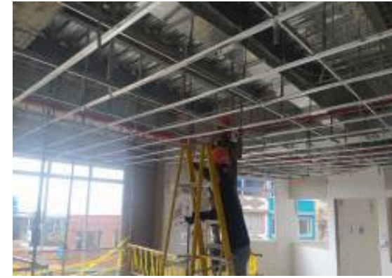
Avance instalación de redes
