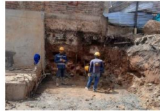
Excavación y Perfilado de terreno ULTIMA trinchera.
