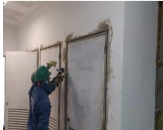
Instalación de Puertas metálicas
