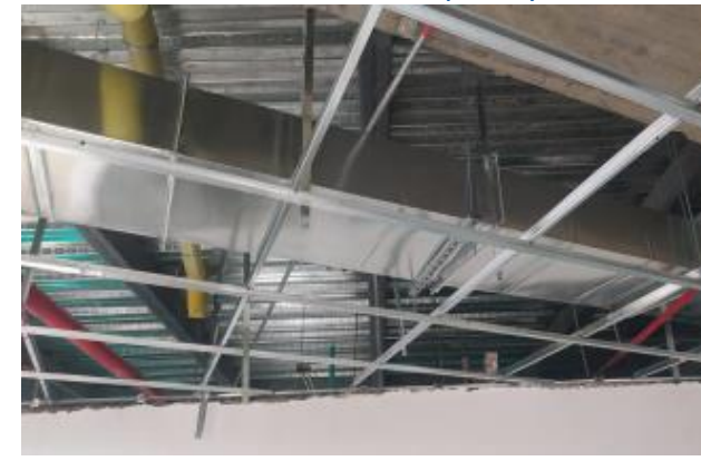
Avance instalación de redes.
