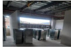
Avance de suministro e instalación de ductos de Aires Acondicionados
