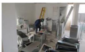
Instalación de Red de Ventilación Mecánica
