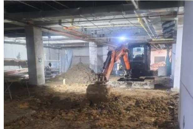
Compactación de Sótano Para armado de contrapiso
