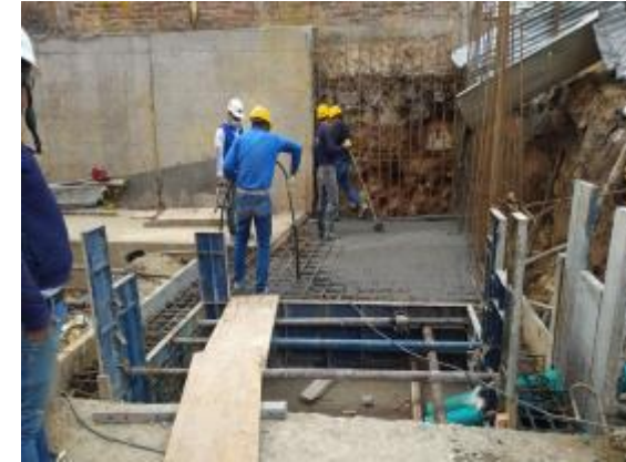
Avance de ultima trinchera del Muro de Contención
