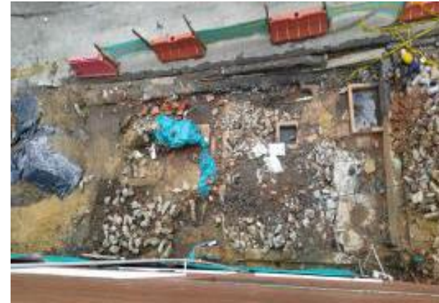
Limpieza para inicio de Exteriores
