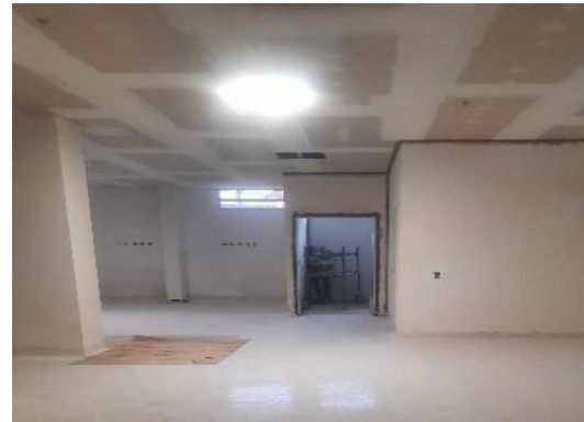
Avance de acabados en pisos y cielos
