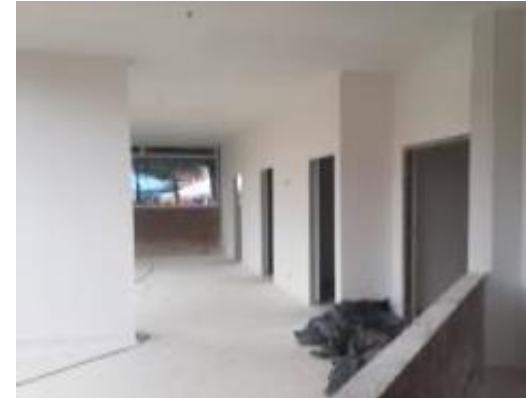
Avance de acabados en pisos y cielos
