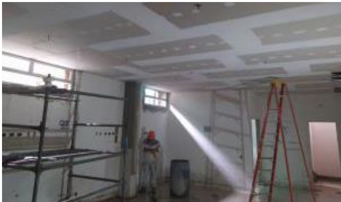
Avance de acabados en pisos y cielos
