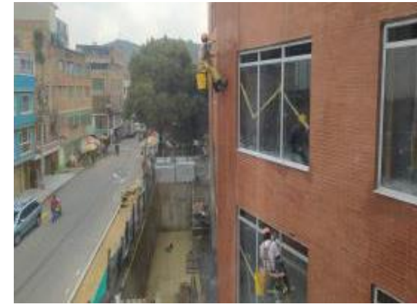
Avance de lavado y sellado de Fachada
