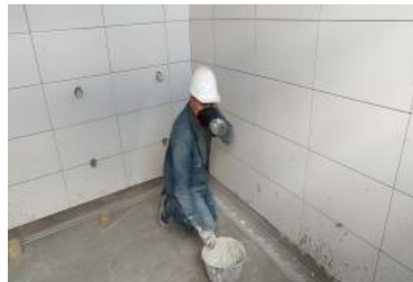
Avance instalación enchapes
