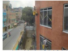
Avance de lavado y sellado de Fachada
