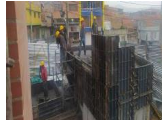
Avance de construcción de tanques
