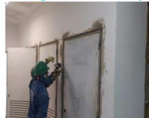
Instalación de Puertas metálicas
