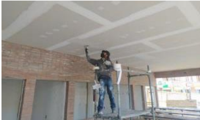
Avance de acabados en pisos y cielos
