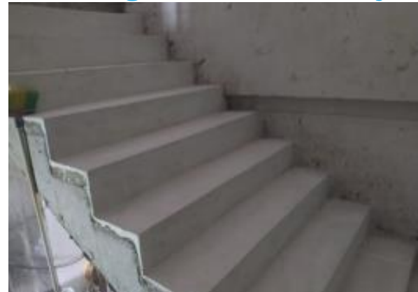
Avance de acabados en Pisos
