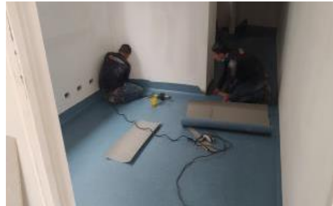
Avance de acabados en Pisos
