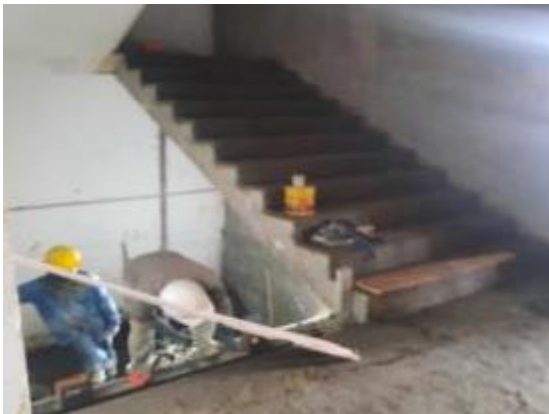
Avance de acabado de escalera principal
