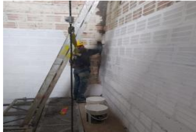
Avance de acabado de Foso de Ascensores.
