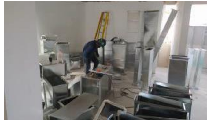
Instalación de Red de Ventilación Mecánica
