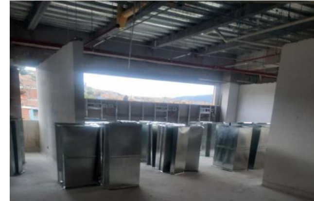
Avance de suministro e instalación de ductos de Aires Acondicionados
