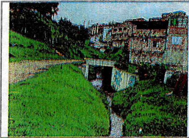
Fotografía No. 1. Vista del Puente 1 tipo Box culvert en concreto.
