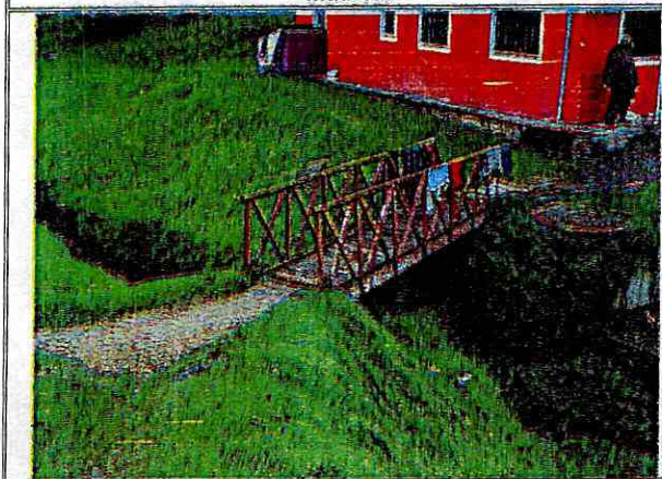
Fotografía No. 11. Vista del Puente 5 tipo Artesanal en madera.
