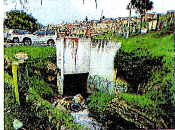
Fotografía No. 6. Vista del Puente 4 tipo Box culvert en concreto.
