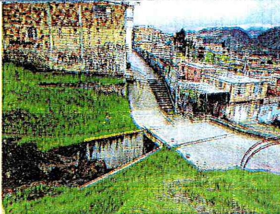
Fotografía No. 5. Vista del Puente 2 tipo Box culvert en concreto.
