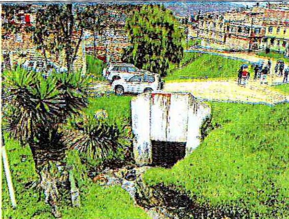
Fotografía No. 7. Vista del Puente 4 tipo Box culvert en concreto.
