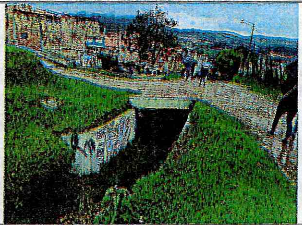
Fotografía No. 2. Vista del Puente 3 tipo Box culvert en concreto.
