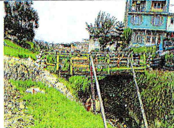
Fotografía No. 8. Vista del Puente 2 tipo Artesanal en madera.
