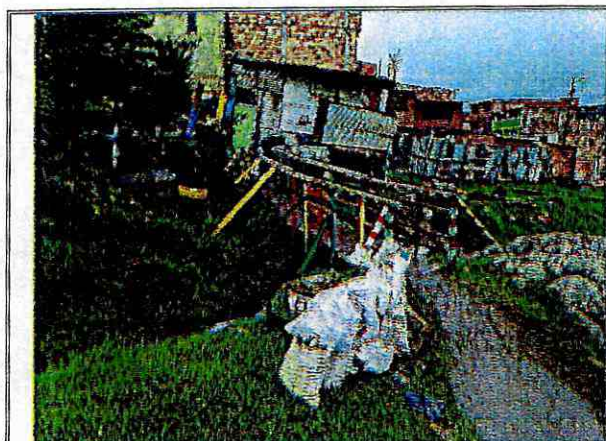
Fotografía No. 9. Vista del Puente 2 tipo Artesanal en madera.
