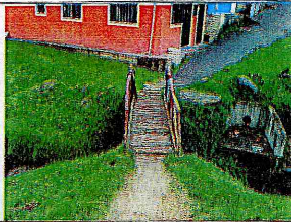
Fotografía No. 12. Vista del Puente 5 tipo Artesanal en madera.
