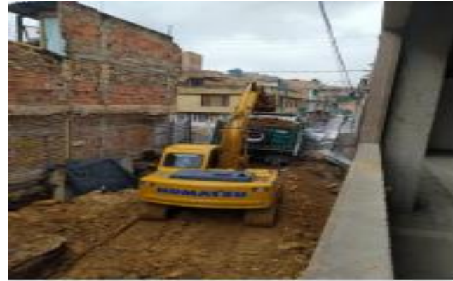
Excavación mecánica área del muro.
