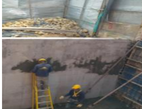
Resane muro de contención fundido el 8 de abril
