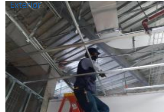
Instalación de estructura de cielo raso falso piso 1 y 2
