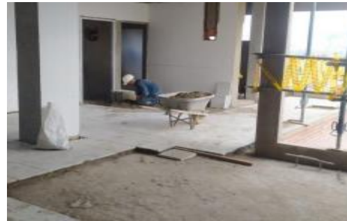
Instalación de piso alfa en nivel 3
