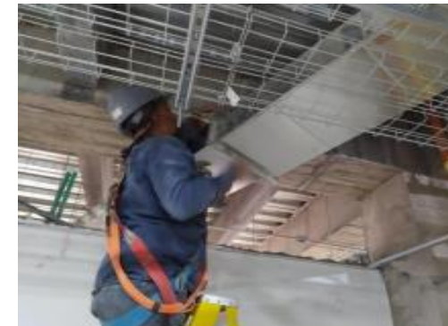
instalación de red de ventilación mecánica piso 2
