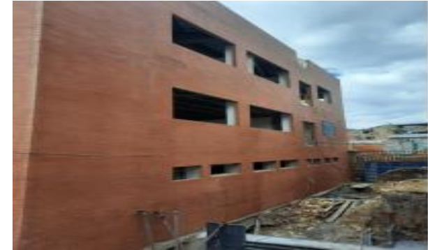
Lavado de Fachada costado sur y oriente
