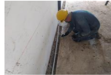
Instalación de tubería hidráulica en hall ingreso piso 2
