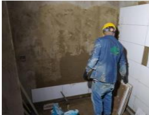
Instalación de enchape de muros en sala EDA nivel 1
