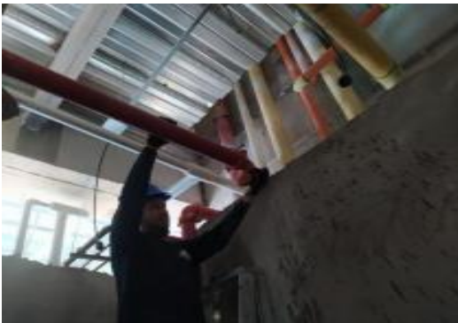
Instalación de red de ventilación en ductos
