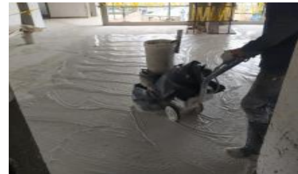
Destronque y pulida de piso alfa nivel 2 y 3
