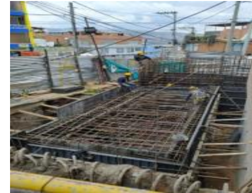
Instalación de testero y formaleta muros de tanque de Reserva de Agua - Exterior
