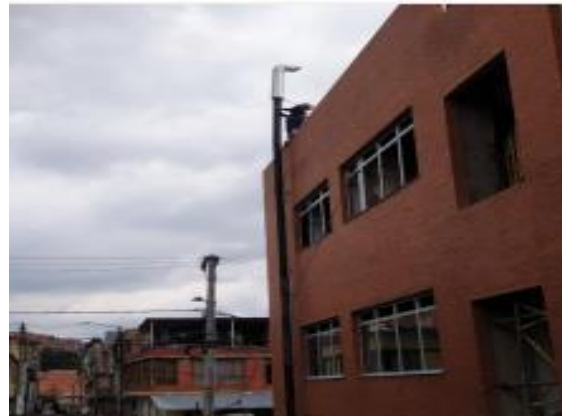
Instalación de planta de suplencia - desfogue
