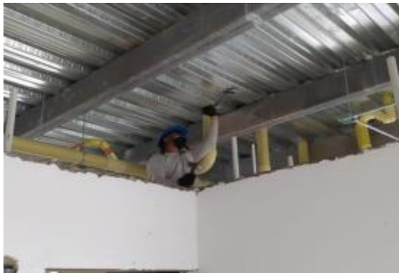
Instalación de la tubería hidrosanitarias batería de baños.
