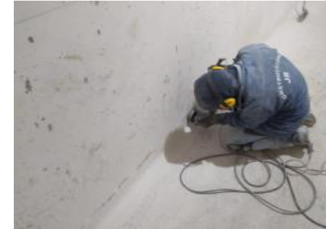
Fundida de guarda escoba en media caña en granito y pulida del mismo piso 3
