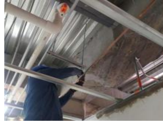
Instalación red Ventilación Mecánica
