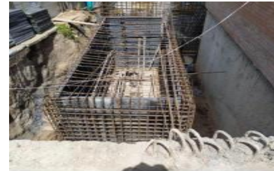
Instalación de testero y formaleta muros y fundida de tanque de Reserva de Agua - Exterior
