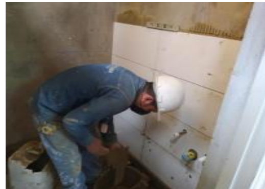
Enchape de muros en batería de baños de la sala EDA piso 1
