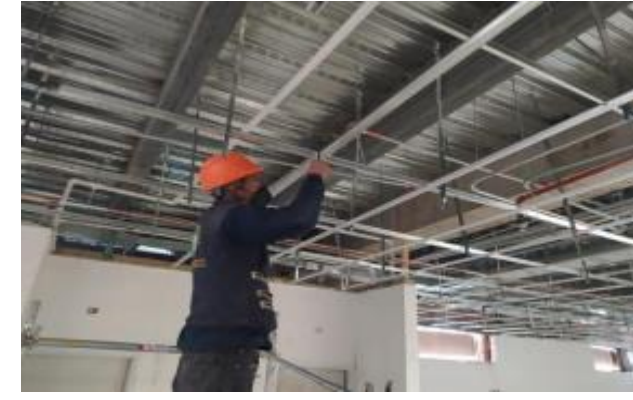
Instalación de la estructura para el cielo raso
