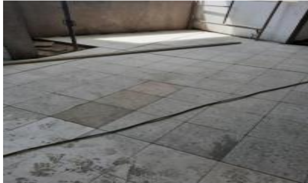
Finalización de enchape de pisos tipo alfa Nivel 3
