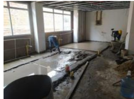
Afinado de piso área de Odontología, previo trazado caja de abastos
