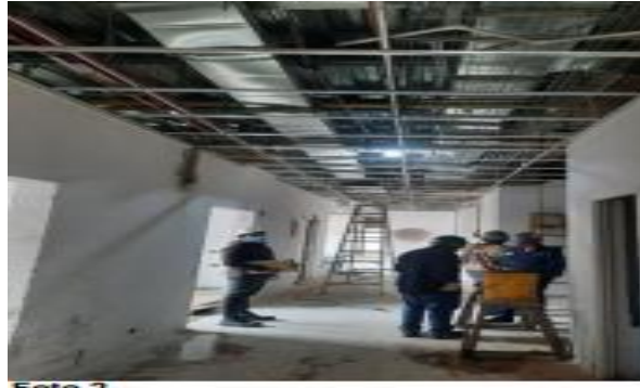
Terminación de armado de cielo raso falso
