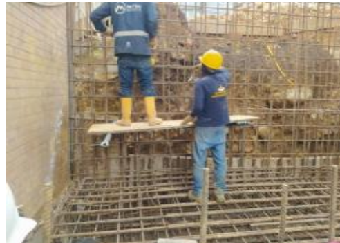
Amarre de Hierro muro de contención nivel - 3,75
