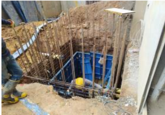
Encofrado de fosos eyectores.
