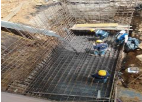
Fundida de zarpa en concreto 0 de 4000 psi
