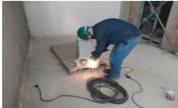
Instalación de red ventilación mecánica
