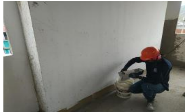
Estuco sobre muros (Nivel 3 Área de Consultorios)
