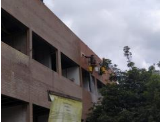
Lavado de Fachada norte e Instalación de Fachaleta en vigas
