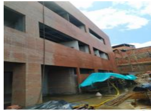
Lavado de Fachadas costado Sur y Oriente
