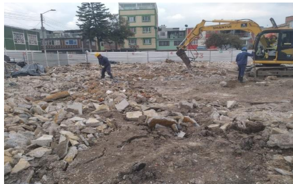
Demolición placa de contrapiso
