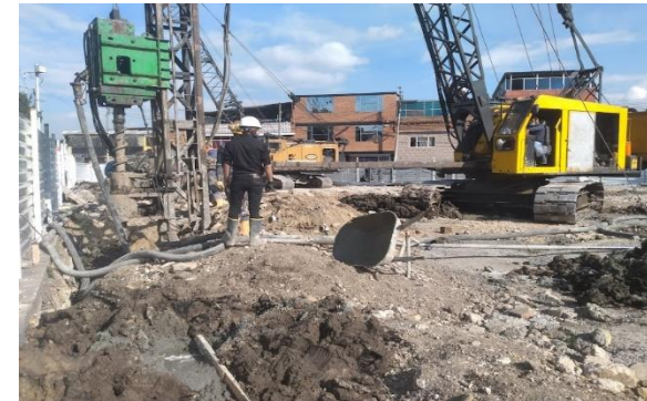
Actividades de perforación y fundida de pilotes.
