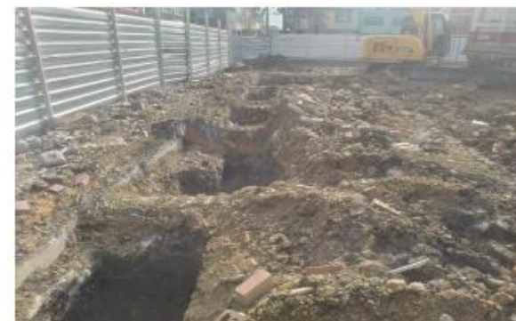
Destape de Vigas de cimentación encontradas para su demolición
