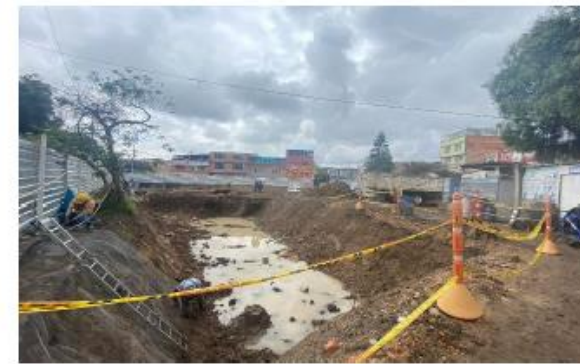
Proceso de excavación Torre 1 y retiro de material
