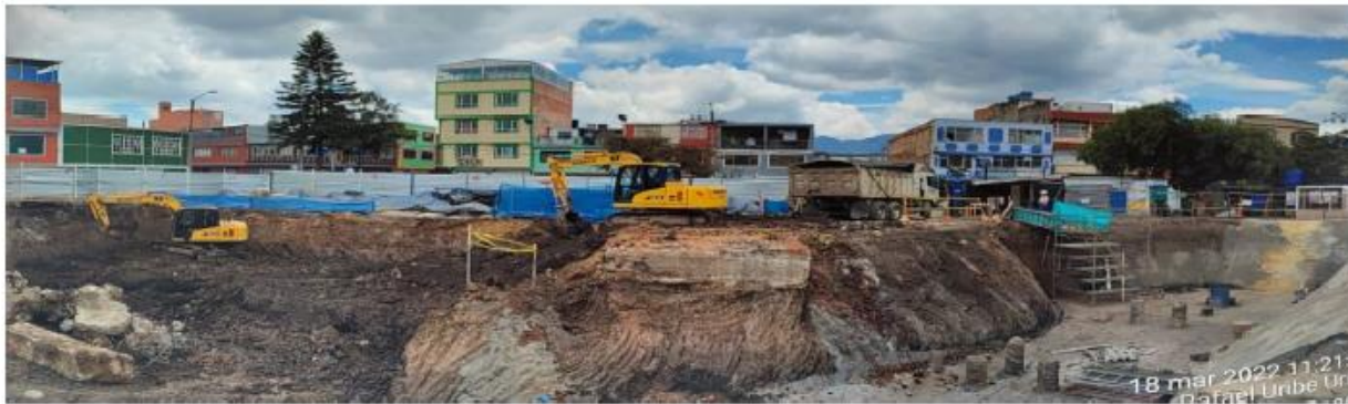
Proceso de excavación Torre 1 y 2, pañete de taludes
