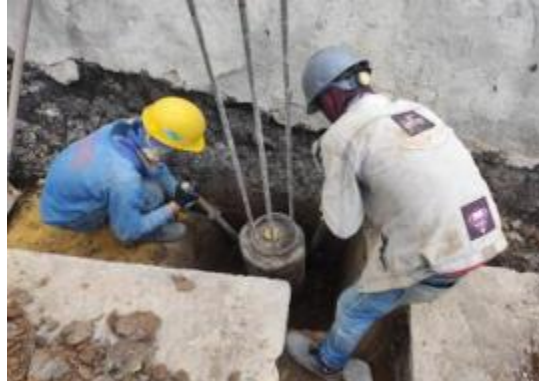
Alistamiento para reforzamiento de los pilotes que presentaron el acero sobresaliente.
