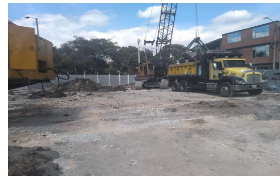
Retiro de material sobrante del pilotaje
