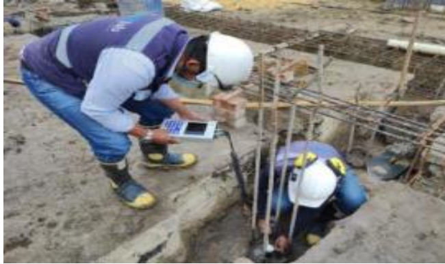
Toma de Pruebas de Integridad
