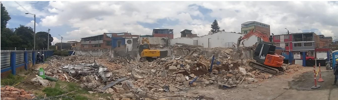
Avance de la demolición del edificio.
