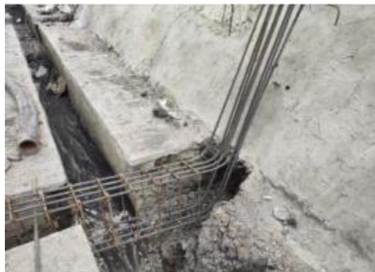
Armado de vigas de cimentación en sentido perpendicular al talud.
