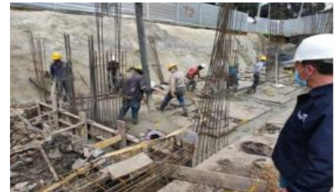
Vista general de fundida vigas y dados Torre 2
