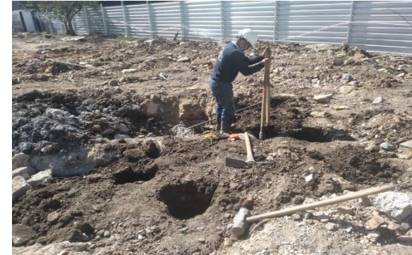
Excavación manual prehuecos para localización de pilotes
