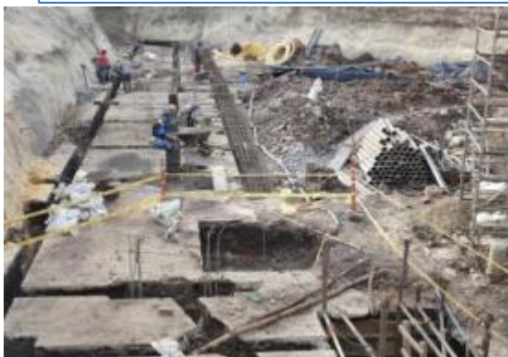
Estado general del avance en obra
