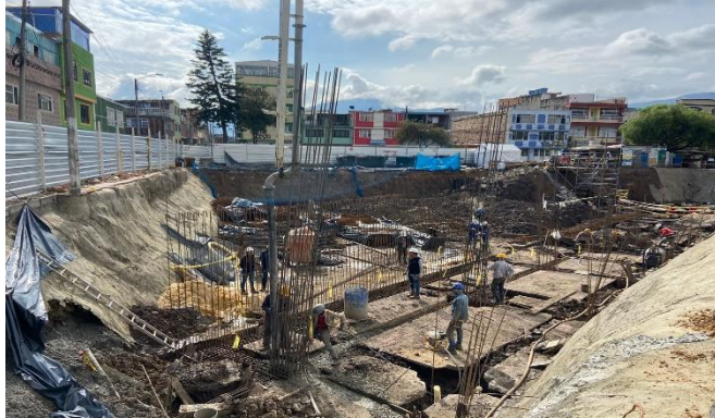
Proceso de fundida vigas de cimentación Torre 2
