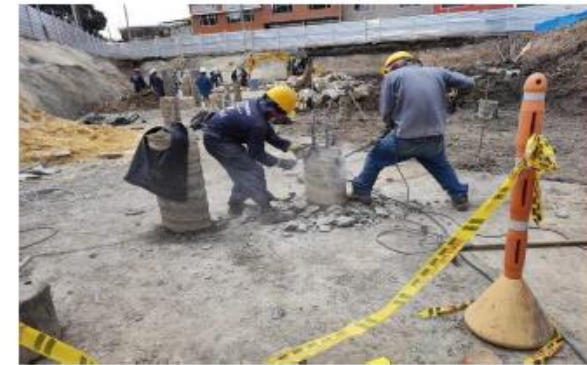
Descabece de pilotes.
