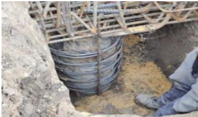
Reforzamiento de pilotes para cortante después de evaluación Estructural por parte del Especialistas.
