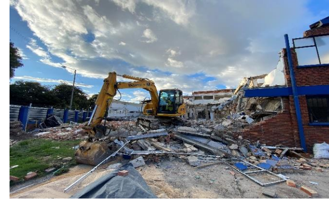
Demolición con máquina
