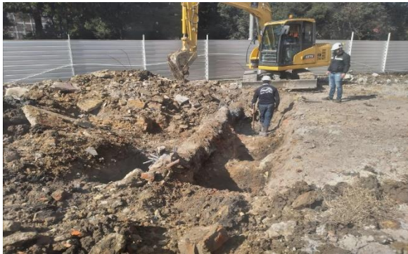
Demolición de cimentación encontrada en excavación para prehuecos, la cual interfería con la máquina piloteadora.
