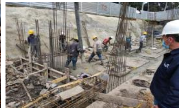
Vista general de fundida vigas y dados Torre 2
