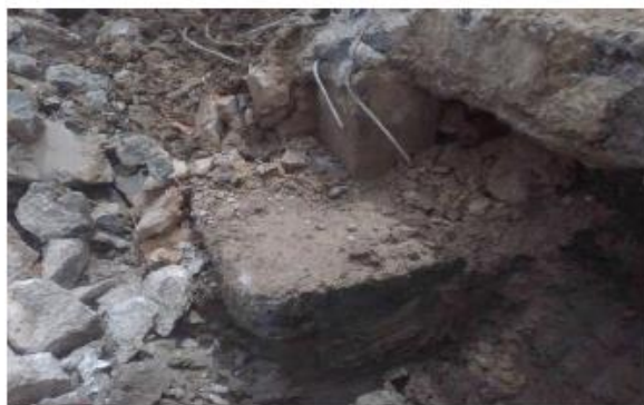
Zapatas encontradas de cimentación antigua edificación
