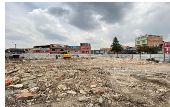
Retiro de la placa y despeje del lote.
