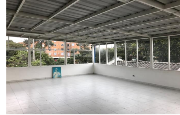
Estado del inmueble antes de la demolición
