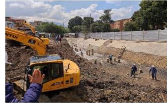
Avance excavación y pañete de taludes
