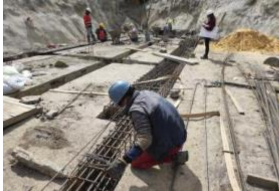
Armado de vigas de cimentación y zarpas para muros de contención Torre 1 y Torre 2
