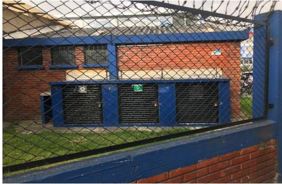
Registro fotográfico estado inicial del inmueble
