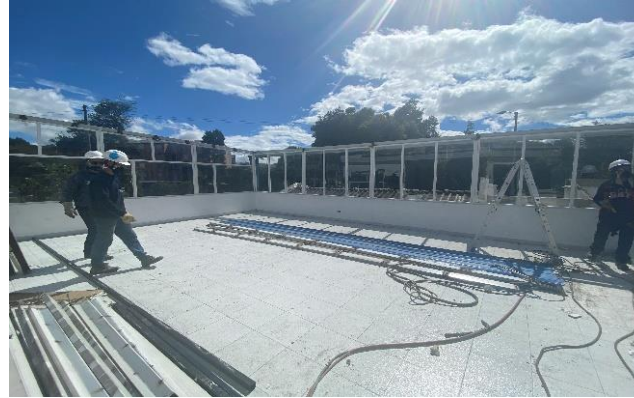
Actividades de desmonte de cubierta e inicio de demolición del edificio
