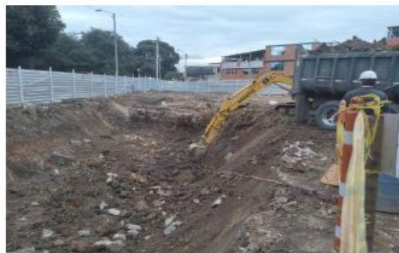
Inicio actividades de excavación.
