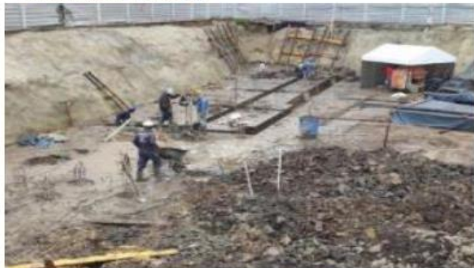
Construcción de red principal de filtro bajo Torre 1 y Torre 2.
