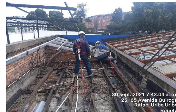
Desmante de tejas y de estructura en el segundo piso.
