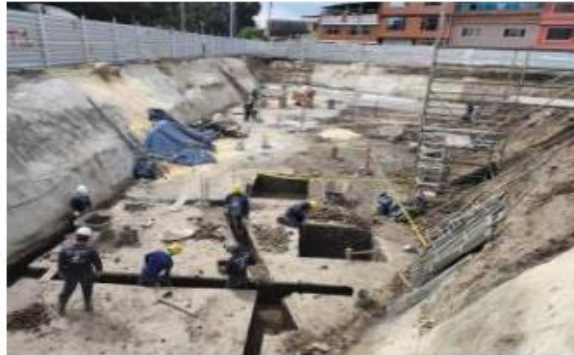
Avance actividades excavación manual para vigas de cimentación.
