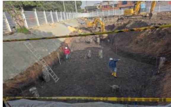
Perfilado de fondo de excavación
