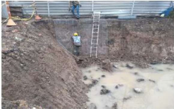
Pañete de taludes
