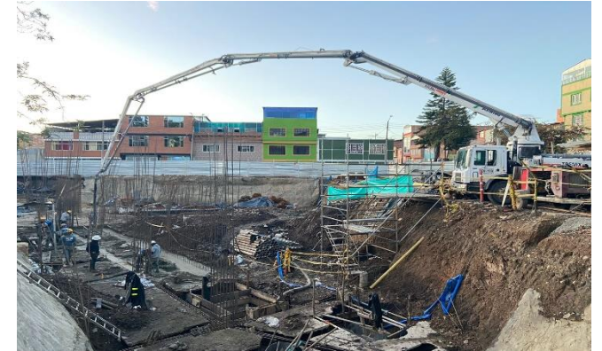
Proceso de fundida vigas de cimentación Torre 1
