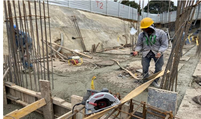
Proceso de fundida vigas de cimentación Torre 2
