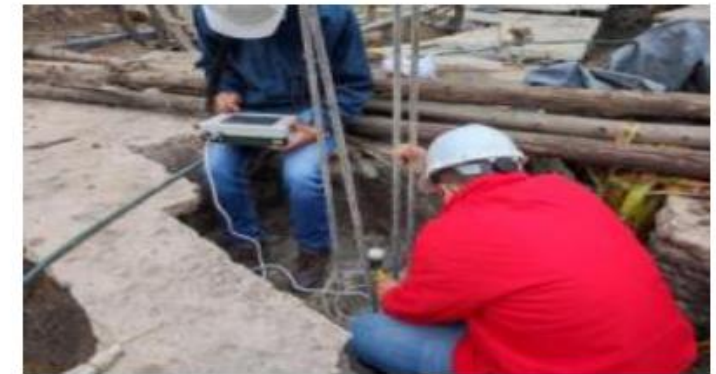
Pruebas de Integridad de Pilotes en obra.
