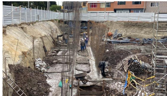
Armado de hierros para columnas y muros de contención.
