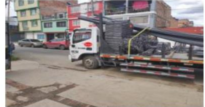
Llegada de acero para cimentación de Torre 2
