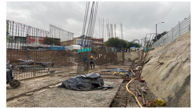
Armado de hierros para columnas y muros de contención.
