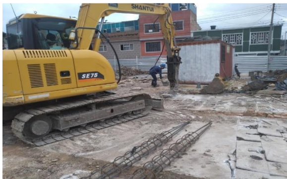
Inicio de demolición placa de contrapiso
