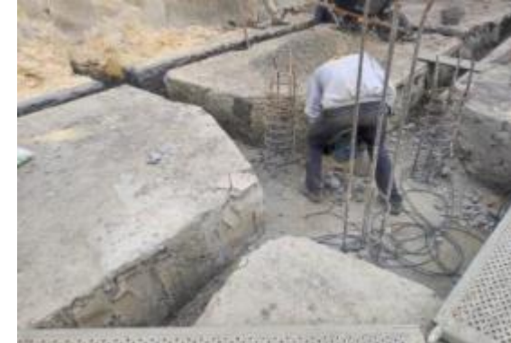
Descabece de pilotes
