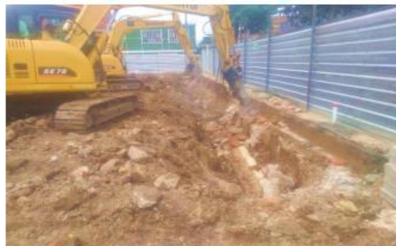
Actividades de excavación y demolición de vigas de cimentación.
