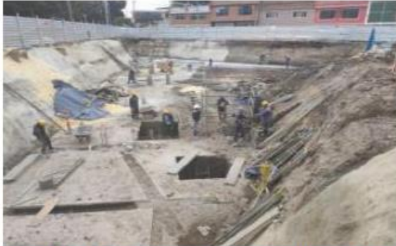
Actividades de excavación manual vigas de cimentación.
