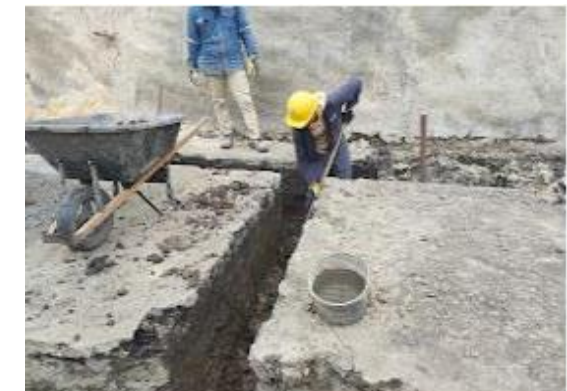
Excavaciones para ramales de filtros.
