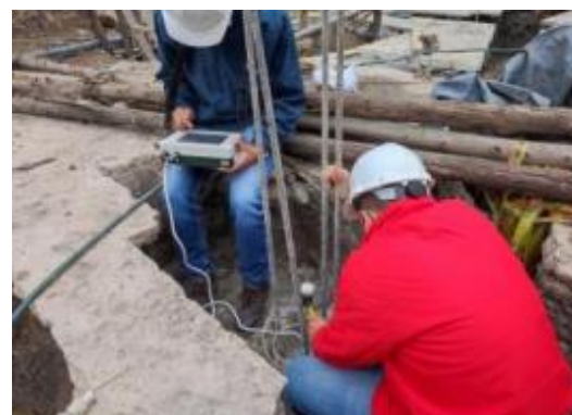
Pruebas de Integridad de Pilotes en obra.
