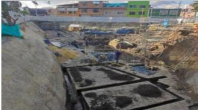
Continuación de excavaciones vigas de cimentación Torre 1.
