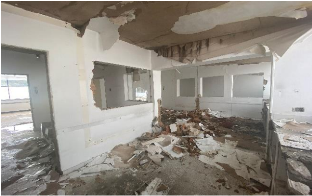
Actividades de desmonte de carpintería e inicio de demolición del edificio
