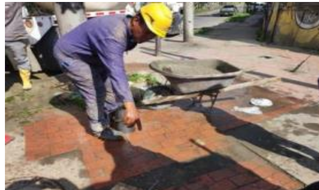
Toma Slump concreto para fundir vigas y dados de cimentación Torre 2.
