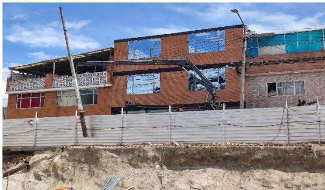
Desmonte de poste de teléfono, cableado sin uso.
