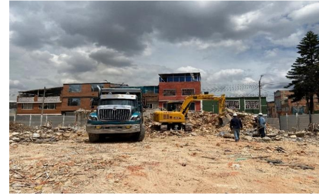
Retiro de escombros
