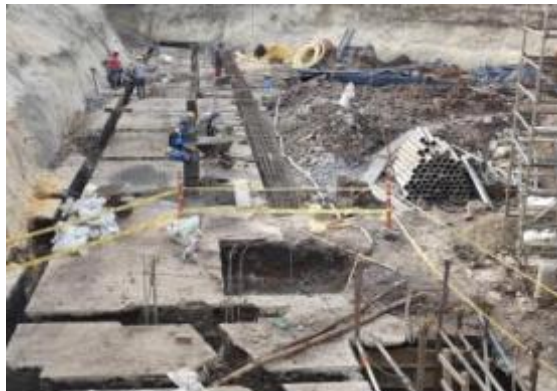
Estado general del avance en obra
