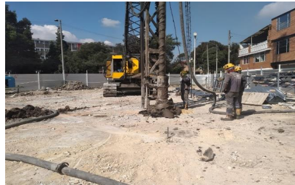
Inicio de pilotaje
