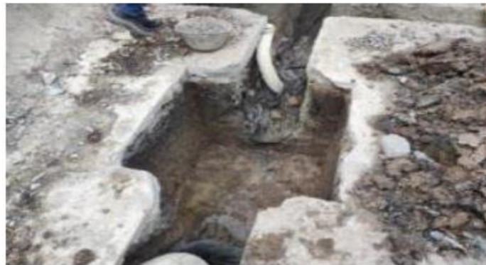
Construcción cajas de inspección de 70x70 mts para inspección de filtros
