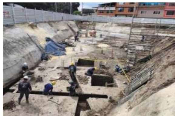
Avance actividades excavación manual para vigas de cimentación.
