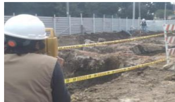
Control de excavaciones por parte de la topografía de la Interventoría
