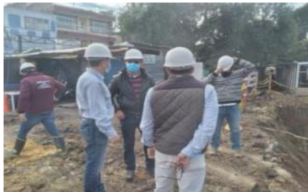
Visita del Especialista de Geotecnia de la Interventoría con el fin de verificar el suelo de acuerdo al estudio de suelos
