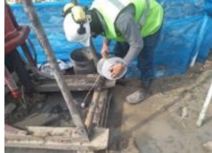
Toma de mediciones el día 23 de Febrero de la instrumentación geotécnica.
