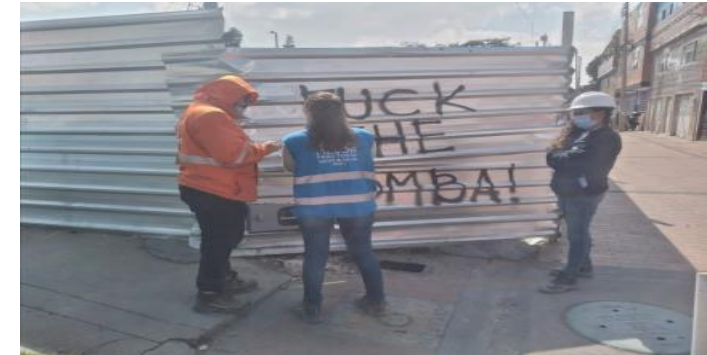
Visita de inspector de la empresa de EAAB para instalación de medidor provisional
