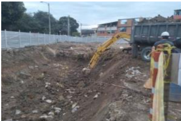
Actividades de excavación sobre el terreno
