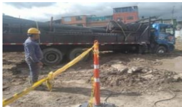
Llegada de una parte del acero para cimentación
