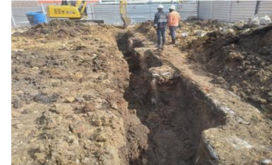
Cimentación de volumen considerable de la antigua edificación la cual se esta demoliendo mecánicamente.
