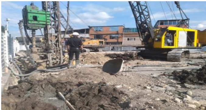
Actividades de perforación y fundida de pilotes
