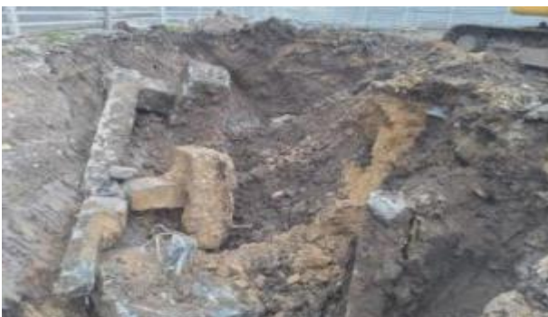
Parte de la cimentación encontrada para ser demolida y retirada de obra, actividades no contempladas en las cantidades iniciales.
