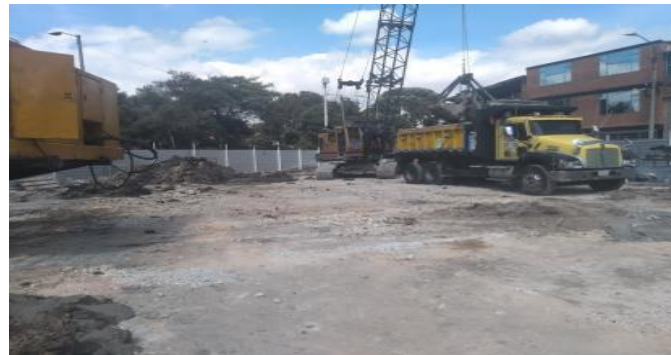
Retiro de material sobrante del pilotaje
