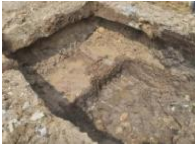
Cimentación de volumen considerable de la antigua edificación la cual se esta demoliendo mecánicamente.
