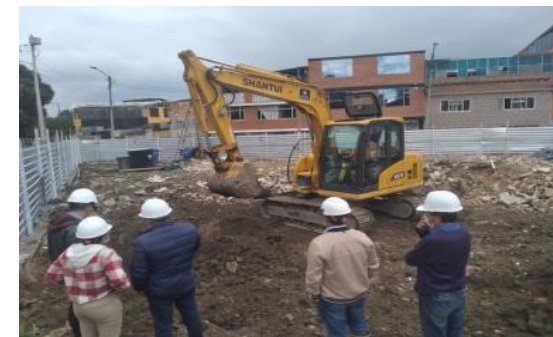
Se lleva a cabo inspección al terreno
