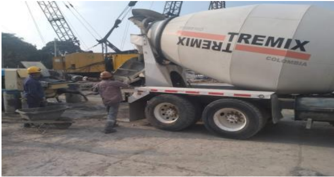
Suministro de concreto autocompactante de 4000 Psi
