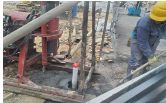
Actividades de perforación para instrumentación geotécnica sobre la calle 35B sur
