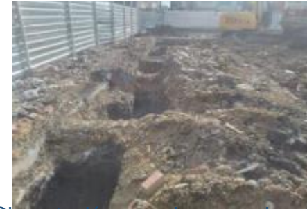
Cimentación de volumen considerable de la antigua edificación la cual se esta demoliendo mecánicamente.
