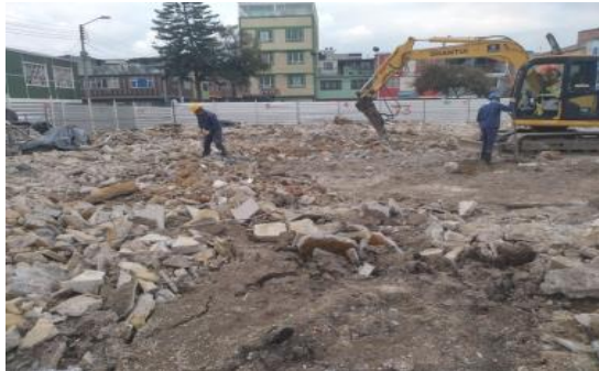
Demolición de losa de contrapiso existente y retiro a botadero autorizado
