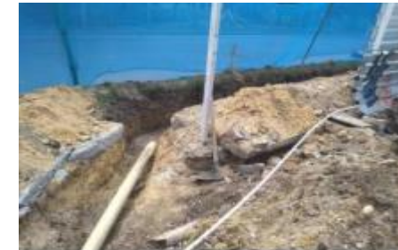
Actividades de excavaciones e instalación de tubería para adecuación red provisional baños de obra sobre el anden de la calle 36 Sur
