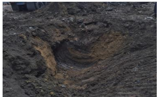
Apique de Terreno para verificación geotécnica
