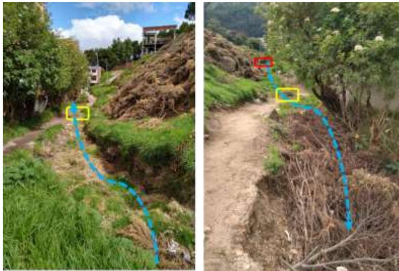
**Imagen 14. Estado actual de la superficie de flujo de la Quebrada Los Olivos luego del paso por la Av. Circunvalar. (cuadro amarillo pozo de conexión de drenajes / cuadro rojo estructura BoxCulvert)**
