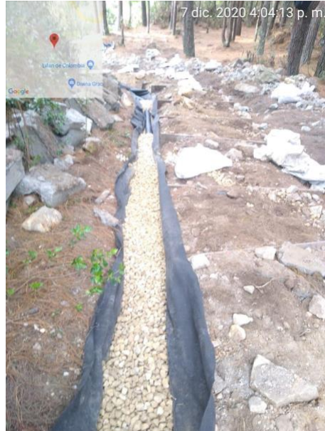
Filtro francés en etapa de construcción (Fotografía para fines informativos)
