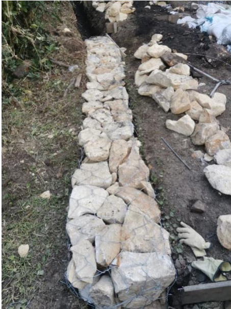
Gavión de contención en fase de construcción (Fotografía para fines informativos)
