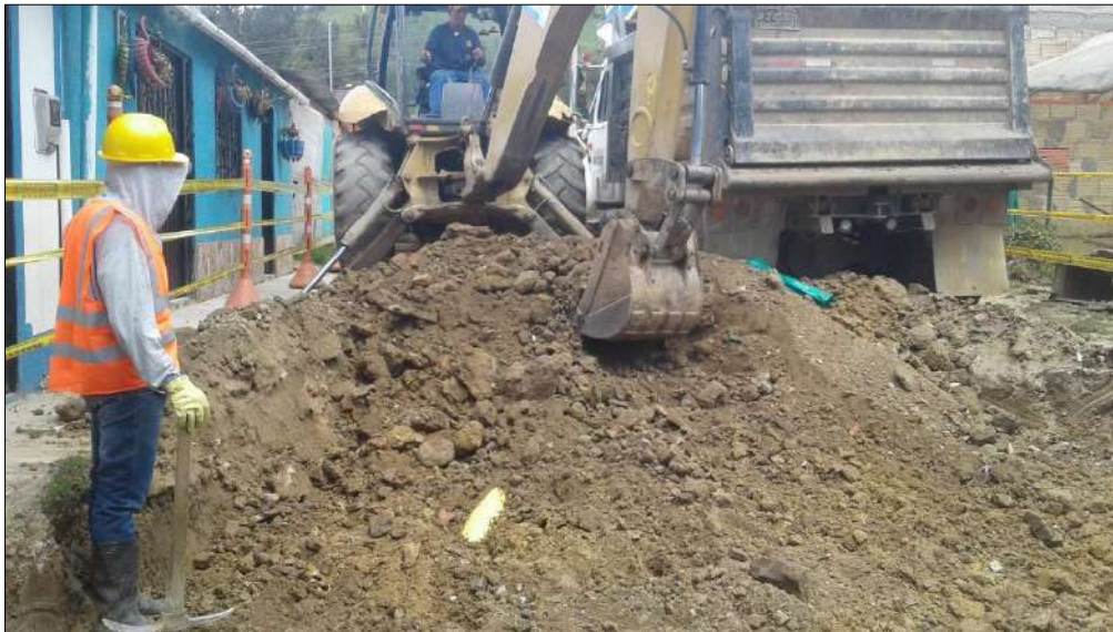
Excavación (cajeo)
