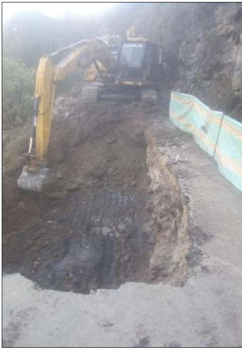
Escavación para el muro de contención
