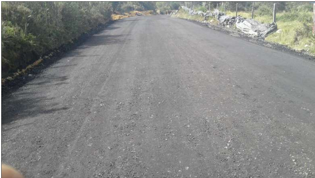
Fresado instalado
