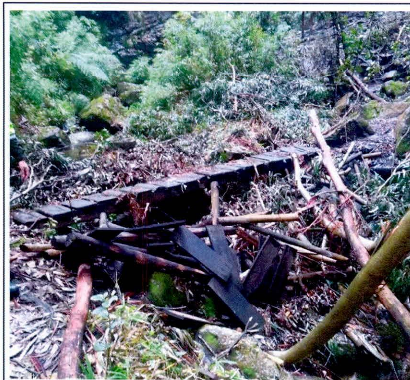
Fotografía 9 Puente de la cascada Las Delicias destruido.
