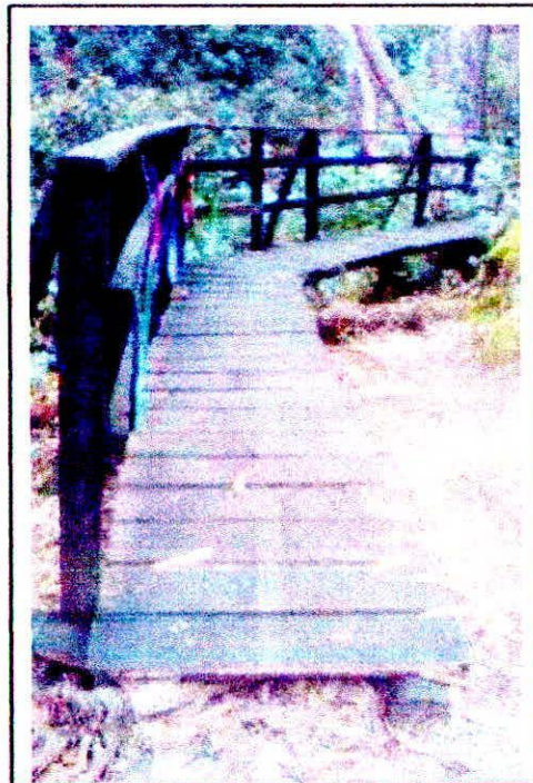
Fotografía 9 Puente punto de partida.
