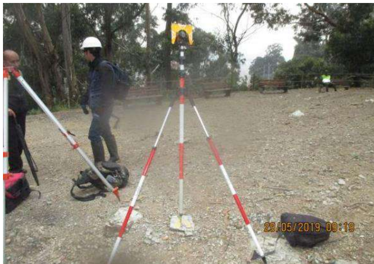
Fotografía 12 Levantamiento Poligonal
